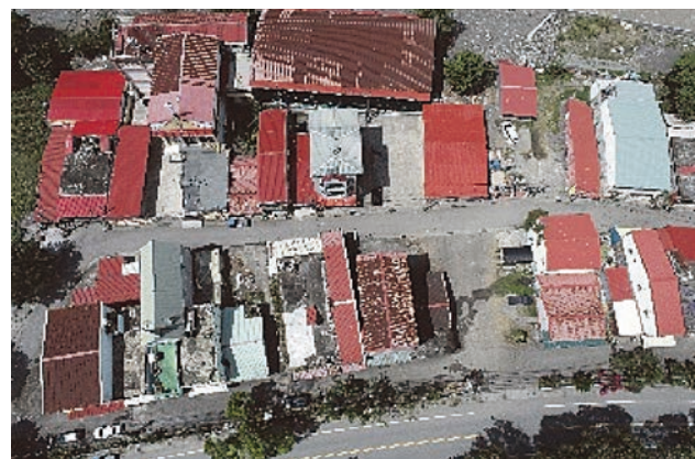
圖 3 實地照片 (荖濃溪東側勤和平台)
