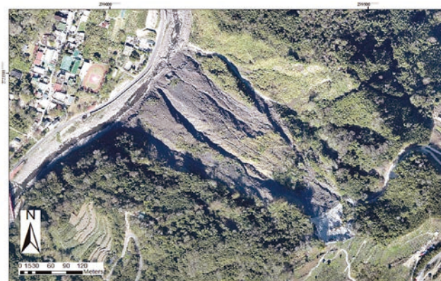
圖 6 新竹秀巒崩塌潛勢區正射影像圖（2020 年 1 月）
