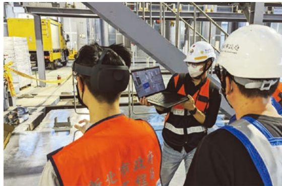
圖 15 透過 MR 設備驗收 BIM 與現場是否一致 (資料來源：本研究彙整)
