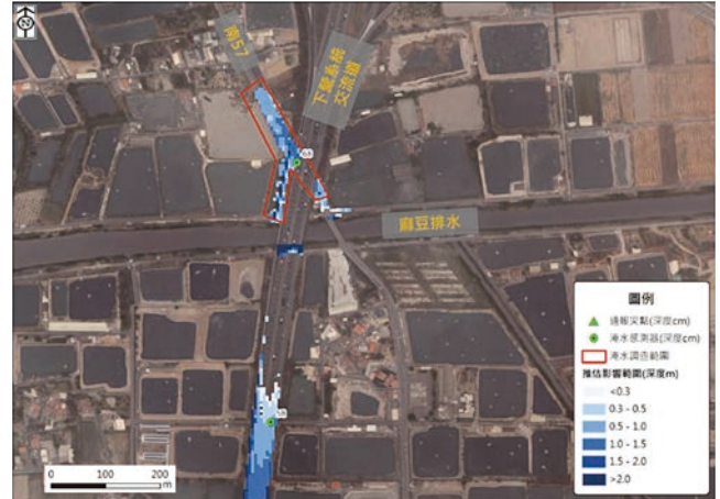
圖 19 民國 110 年 0604 豪雨事件臺南市麻豆區南 57 線高速公路涵洞附近積淹水情形
