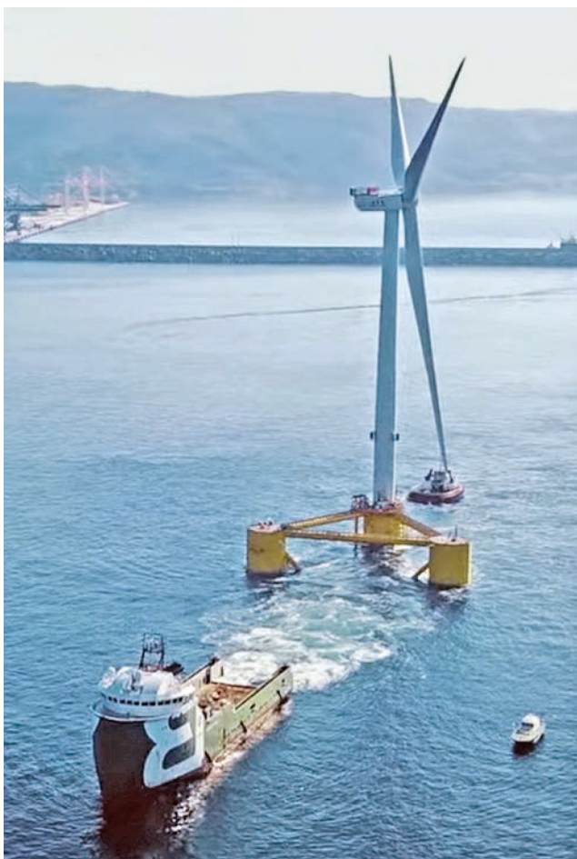
圖 10 Windfloat Atlantic 浮式風場之錨索牽引補給船施工案例 [27]
