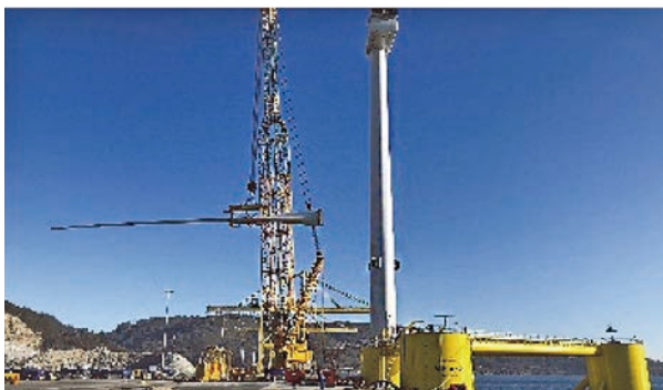
圖 7 Windfloat Atlantic 風場預組裝及拖航照 (圖片來源：Windfloat Atlantic | Offshore wind energy (windfloat-atlantic.com))
