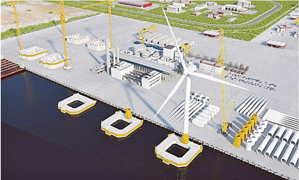
圖 6 駁船式浮台港口組裝示意圖（圖片來源：BW Ideol 官方網站 [4] ）
