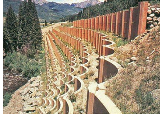
I-70 CLENWOOD CANYON 採用鋼片加勁擋土牆並採預鑄混凝土拱形面板，是力與美的結合
