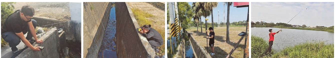
(a) 使用手持雷射測距儀量測渠寬 (b) 使用雷射測距槍量測渠寬 (c) 使用 RTK 量測渠頂高程 (d) 使用 DEEPER 智能聲納探測器量測水深
