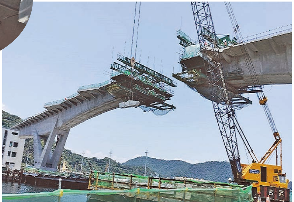
圖 20 節塊打除作業 (2)
