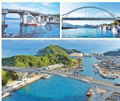
南方澳跨港大橋不同時期照片
