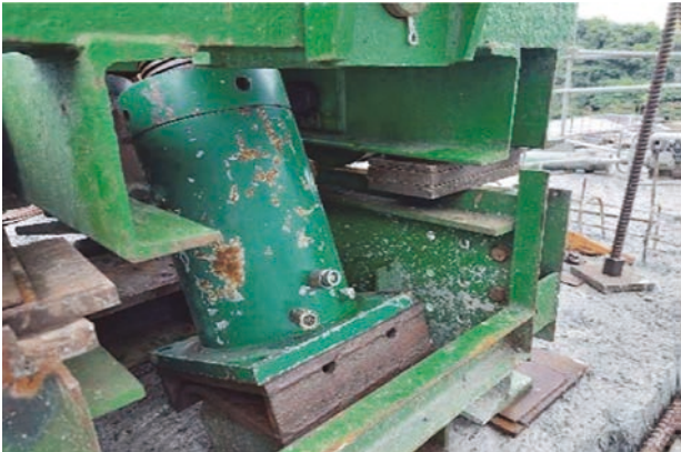
圖 17 工作車鋼墊塊變形
