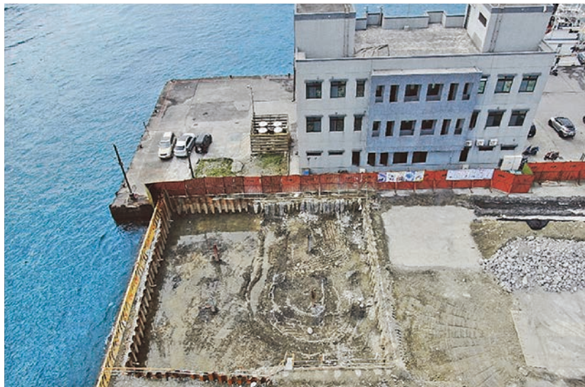
圖 15 P6 橋墩基礎擋土支撐照片
