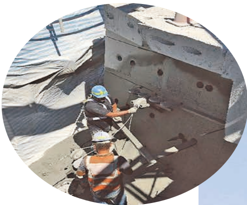
圖 19 節塊打除作業 (1)
