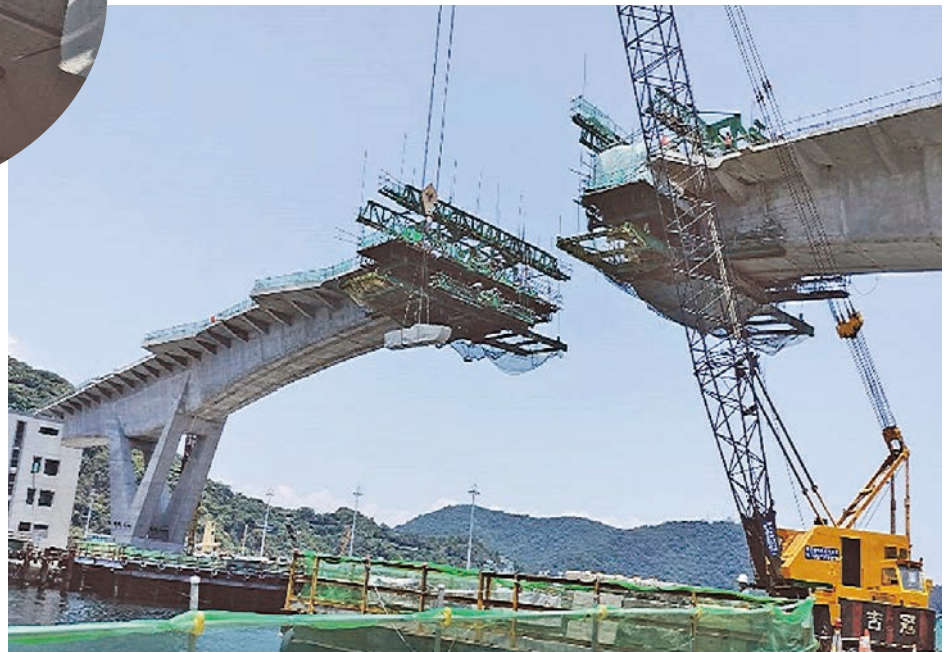
圖 20 節塊打除作業 (2)
