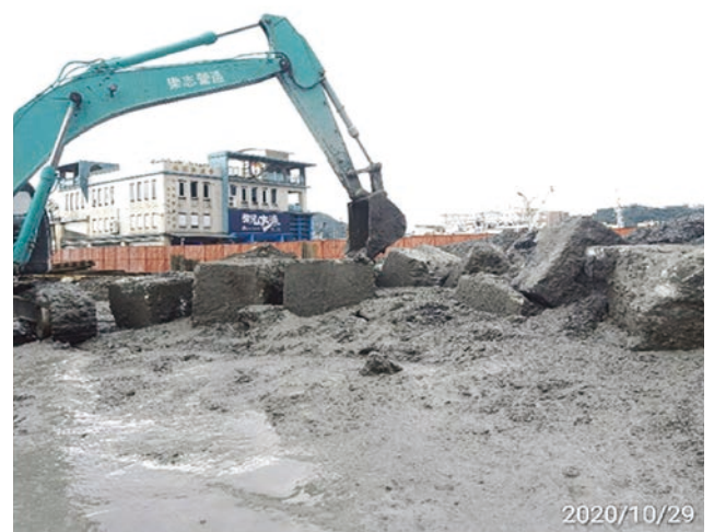
圖 14 混凝土地下障礙物
