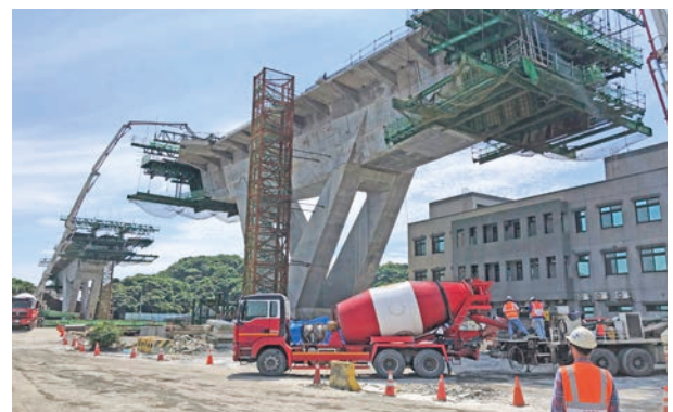
圖 6 懸臂工法施工照片
