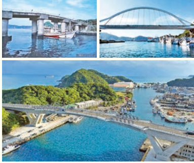
南方澳跨港大橋不同時期照片
