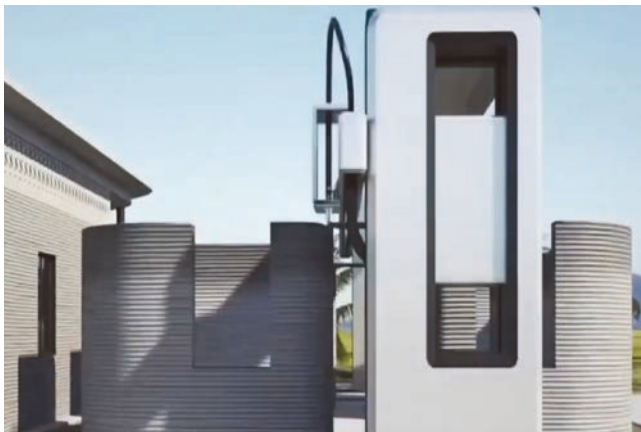
圖 17 利用 3D 列印技術進行房屋「印製」 [4]
