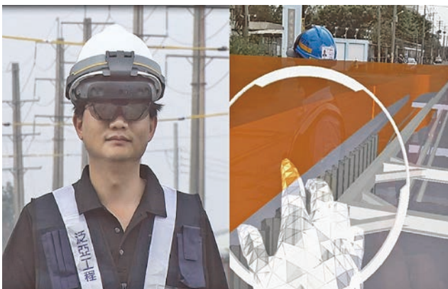
圖 15 利用 MR 混合實境技術輔助道路挖掘施工
