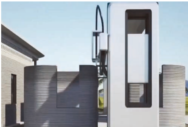
圖 17 利用 3D 列印技術進行房屋「印製」 [4]
