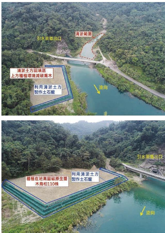
圖 13 引水隧道出口渠道土石籠護岸施工現場圖
