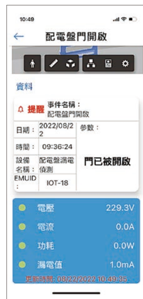
圖 17 配電盤即時電壓、電流、功率及漏電值訊息 (漏電值大於 30 mA 會再另跳告警訊息)
