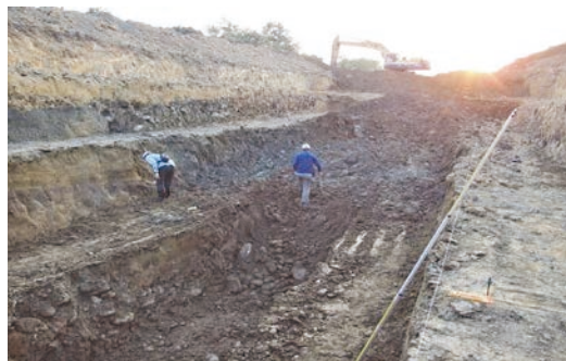
槽溝清理作業
