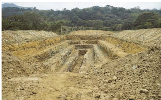
槽溝開挖完成全貌
