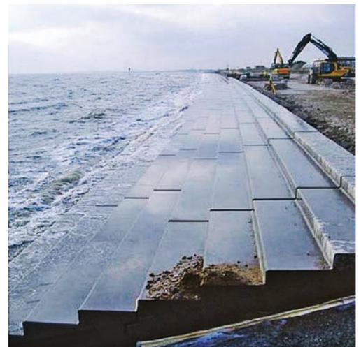
圖 3(b) 採預鑄及水運方式之 Dymchurch Frontage A 河堤工程
