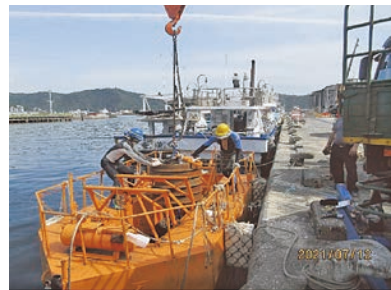
港邊組裝浮標錨繫及錨碇
