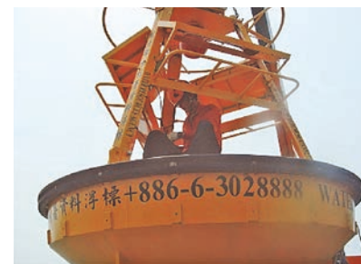
組裝浮標控制箱及接線
