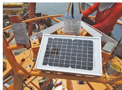
組裝浮標太陽能板與 AIS 警示燈
