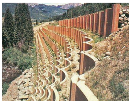
I-70 CLENWOOD CANYON 採用鋼片加勁擋土牆並採預鑄混凝土拱形面板，是力與美的結合
