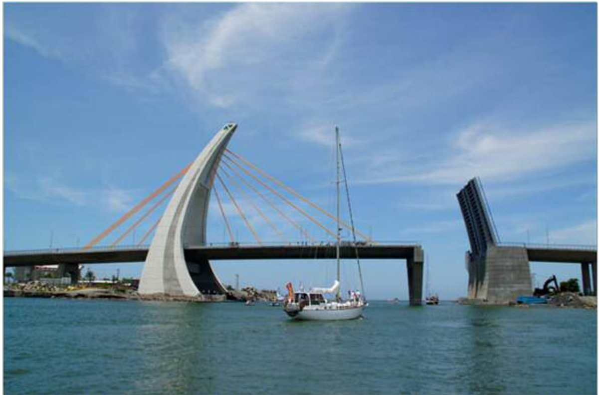
單塔不對稱斜張橋，全長 155m(100m+55m)；雙向分離單葉舉升式活動橋
