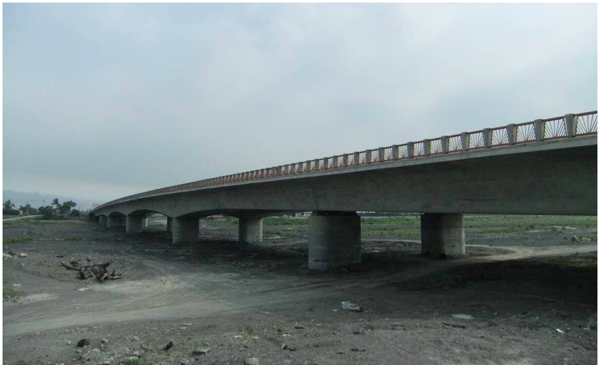
跨越林邊溪，橋梁長度 400m，配置大跨距之預力箱型梁橋，主跨徑 84m
