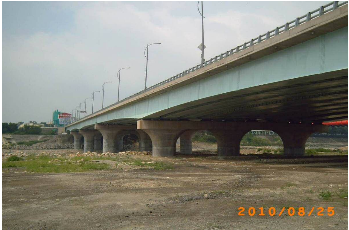
橋長 640m，上部結構為大跨徑鋼箱型梁，全寬 41m
