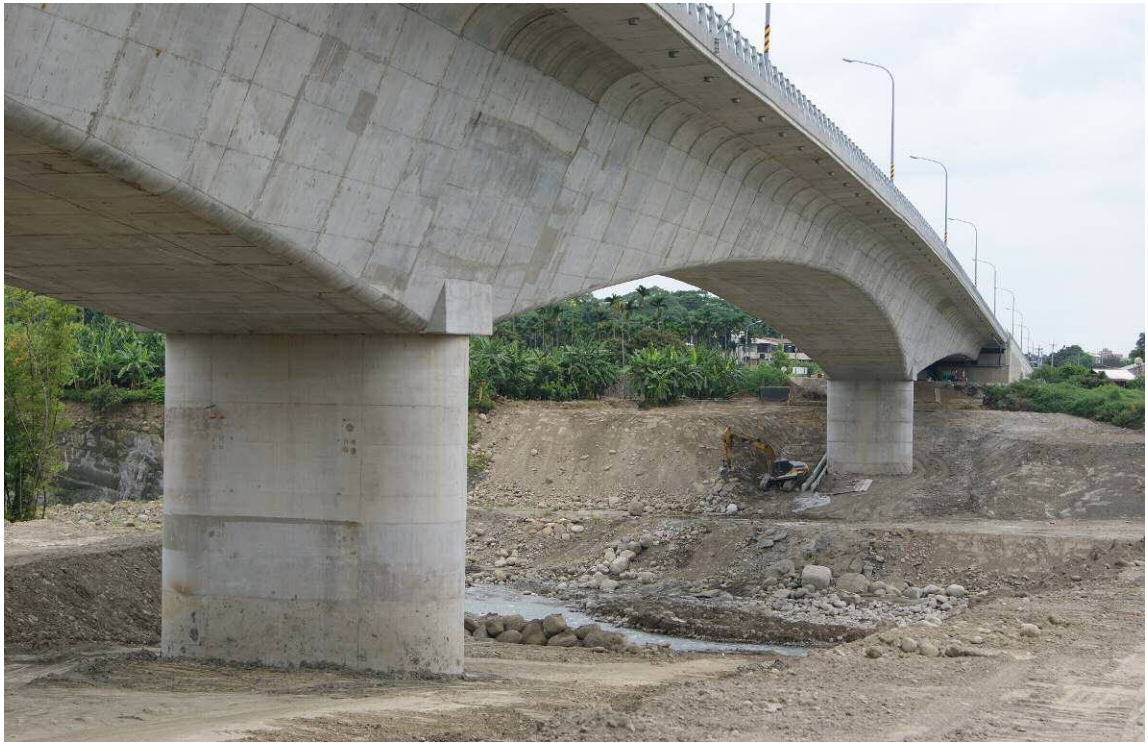
台 18 線進入阿里山風景區之重要橋梁，長 490m，主跨徑 145m
