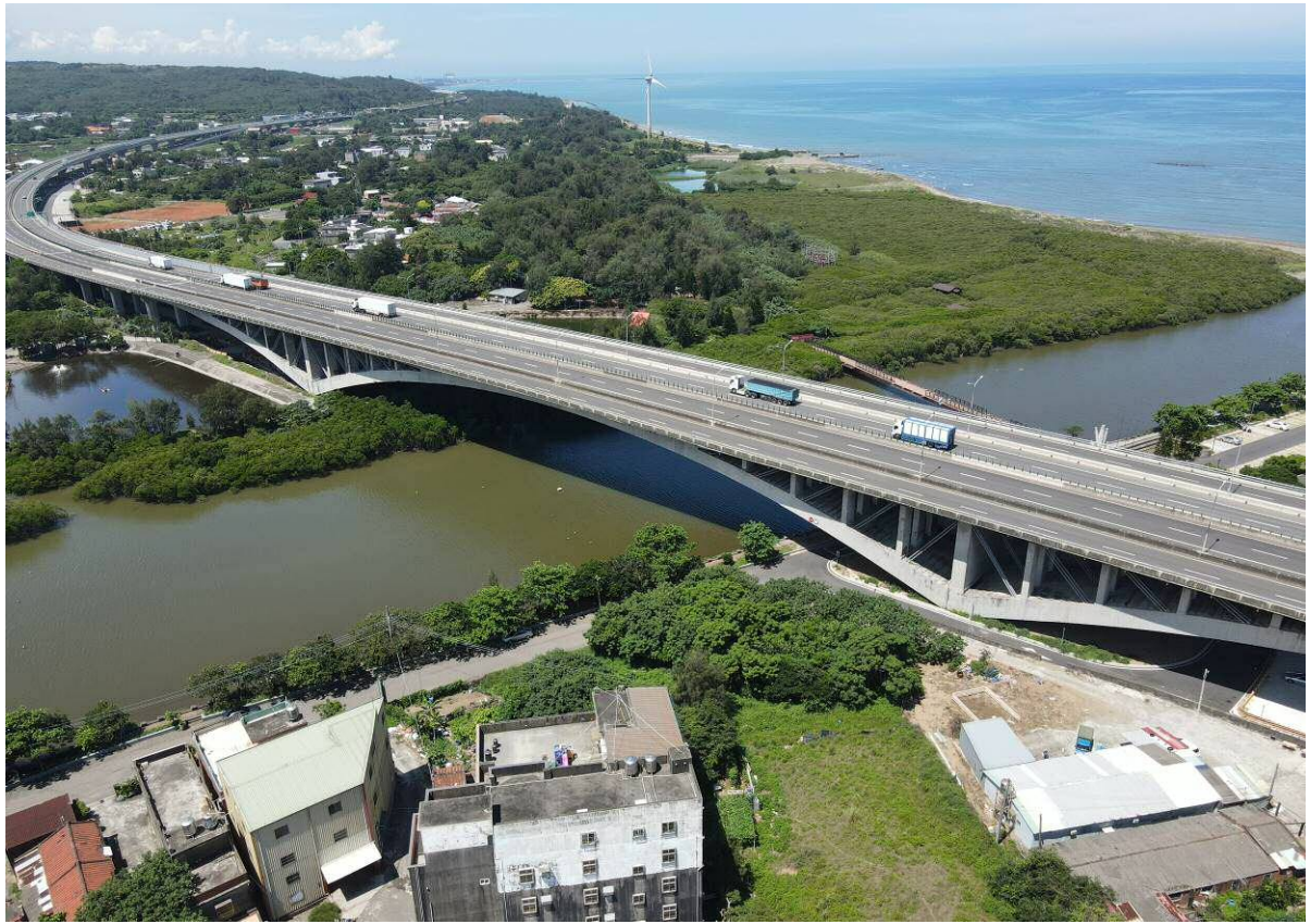
三跨連續預力混凝土加肋拱橋，橋梁全長 380m(100m+180m+100m)
