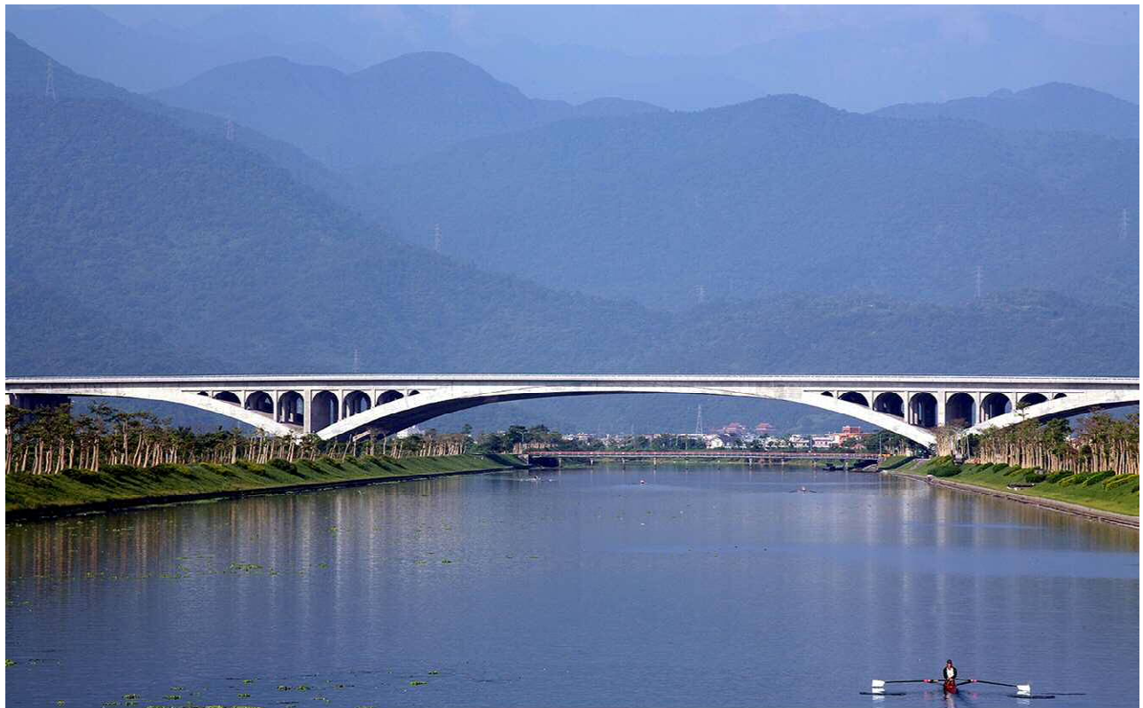
三跨連續加肋式預力混凝土拱橋，橋梁全長 375m(94m+187m+94m)
