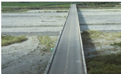
(e) 上部結構無明顯損傷，受損程度 D
