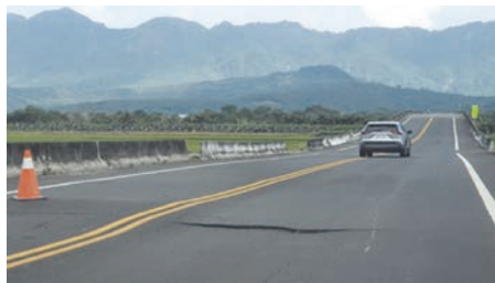
(a) 西側道路隆起 & 路面 AC 開裂，受損程度 C
