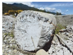
(e) P3 橋墩柱底混凝土澆鑄介面斷裂，鋼筋斷裂傾倒，受損程度 F
