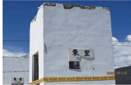
東里車站月台候車雨棚震損，已拆除
