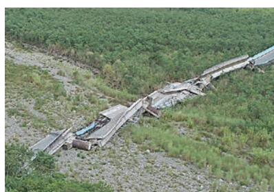
(c) P3 ~ P6 橋墩向下游側（北）傾倒，受損程度 F
