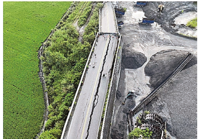
(b) 引道路堤擋土牆位移，受損程度 A
