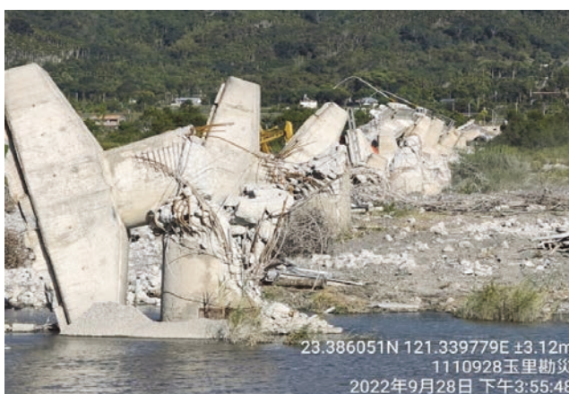
(c) 橋墩斷裂傾倒，受損程度 F
