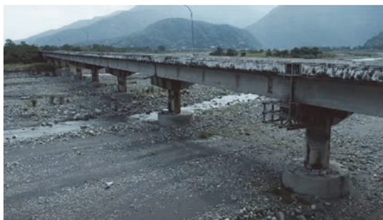
(f) 河川區域橋墩柱受剪力保護層破裂，受損程度 B
