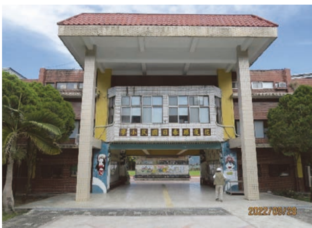
經耐震補強之校舍，震後可以正常教學使用
