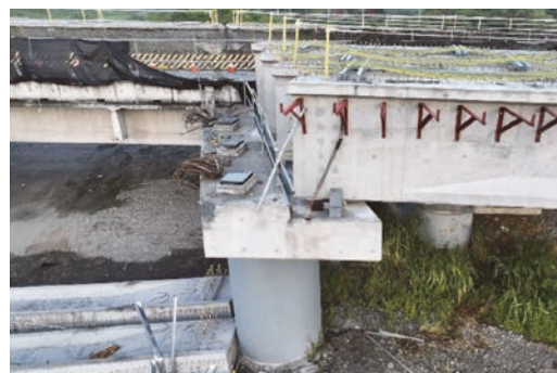
(f) 帽梁上方大梁止震塊鋼筋變形，受損程度 F
