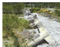
(d) P6 ~ P3 橋墩傾倒（上構已敲除）
