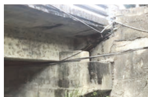
(c) 橋台背牆裂損 受損程度 C
