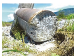
(a) P4 橋墩柱底混凝土澆鑄介面斷裂傾倒，受損程度 F
