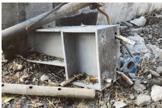
(e) 鋼製臨時止擋塊拔出掉落
