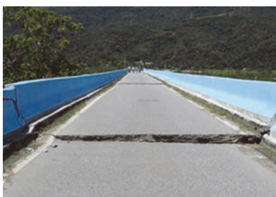
(f) P13 橋墩之上構向東推擠，I 梁滑移至支撐墊外，受損程度 B
