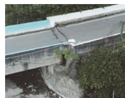
(f) S14 上構擠壓橋台，路面隆起，受損程度 A
