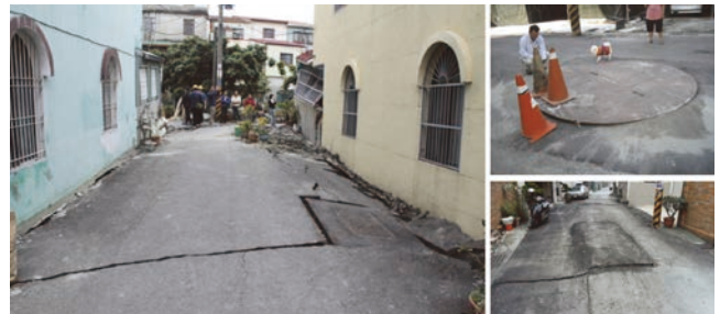
圖 9 發生於新市區三民街地表及安南區府安路之地下人孔的隆起
