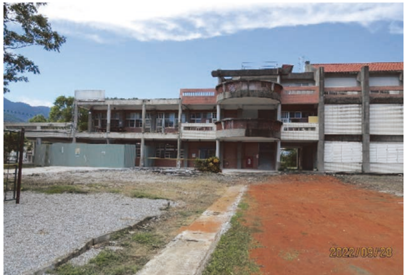
幼兒園教室沒有耐震補強校舍，一樓圓柱受到嚴重震損
