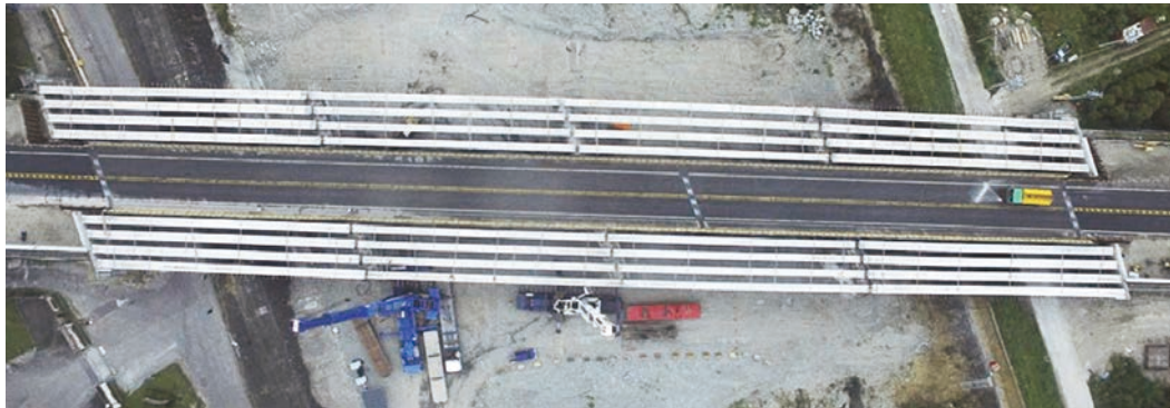
圖 11 玉興橋拓寬新建橋梁剛完成大梁吊放 (111.03.20 攝，公路總局提供)
