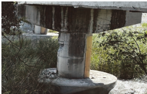
(c) 橋墩柱受剪力保護層破裂，受損程度 B
