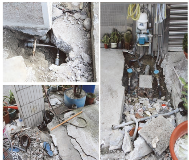
圖 10 發生於新市區三民街之自來水管線斷裂
