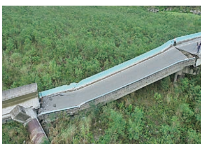
(b) P6 橋墩、S7 上構損壞情形，受損程度 F
