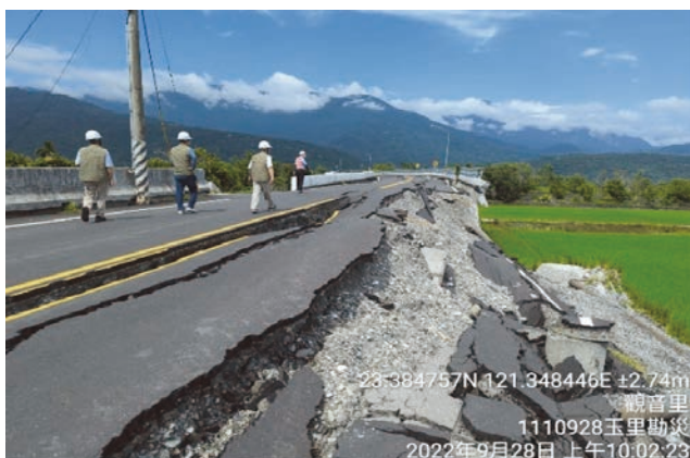
(e) 引道擋土牆崩塌，路面破裂沉陷
