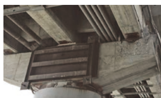
(d) 支承墊滑移及止震塊受損， 受損程度 B
