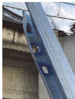
(d) 連結槽鋼固定孔變形
