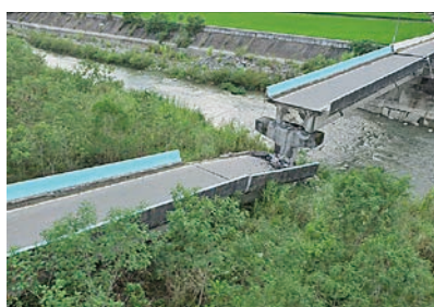
(a) S2 上構位移，造成 S2 上構落橋，大梁及橋面斷裂，受損程度 F
