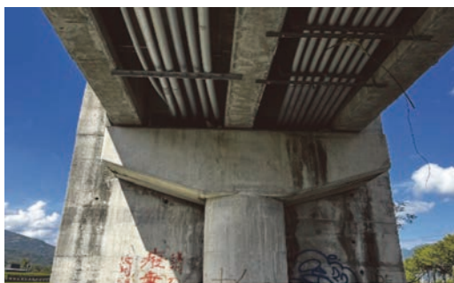
(a) 上構 I 梁位置偏移，受損程度 B
