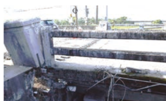
(a) 橋台受擠壓伸縮縫突起， 受損程度 C
