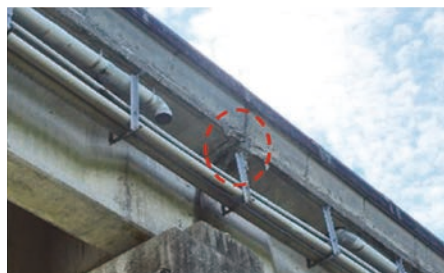
(f) 護欄及橋面板擠壓受損，受損程度 C
