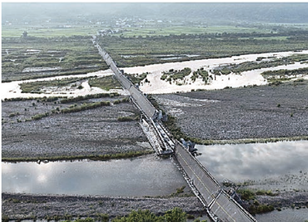
(a) 全橋崩塌，受損程度 F
