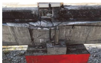
(e) 大梁受推移梁端龜裂， 受損程度 B
