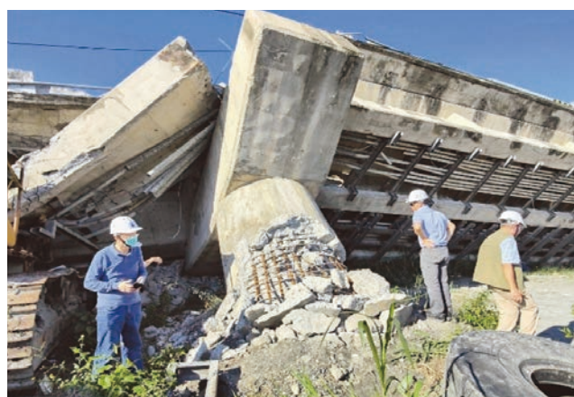
(d) 橋墩斷裂，上部結構翻覆
