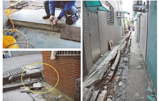
圖 3 發生於安南區德安街口（左上）、中西區文和街（左下）、新市區三民街（右）之地表不均勻沈陷
