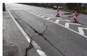
(a) 引道路面凹陷及裂損 受損程度 C
