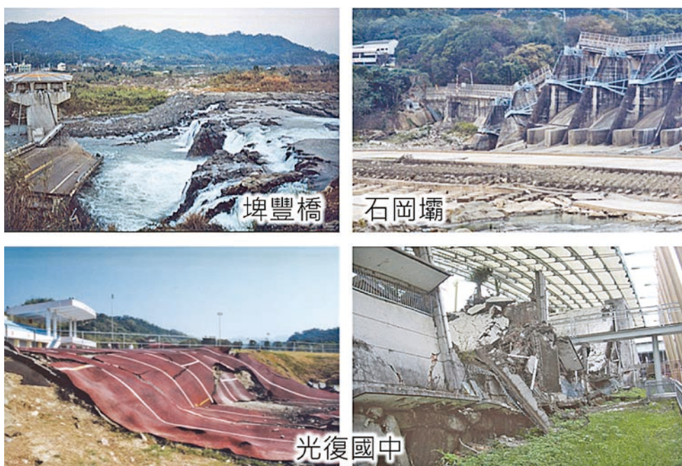
圖 1 集集地震造成之災損 [3]
