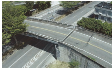
(d) 東橋 A2 橋台處伸縮縫開裂、進橋版處路面隆起裂損，受損程度 C
