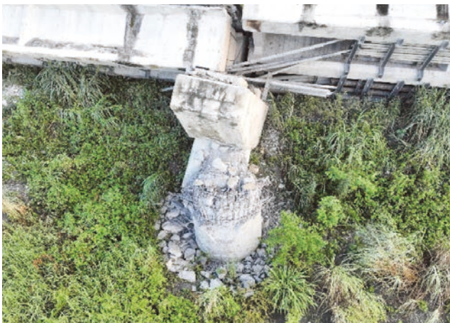
(e) 橋墩斷裂，鋼筋外露，受損程度 F
