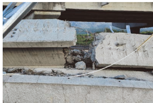
(b) 預力梁掉落於弱軸斷裂
