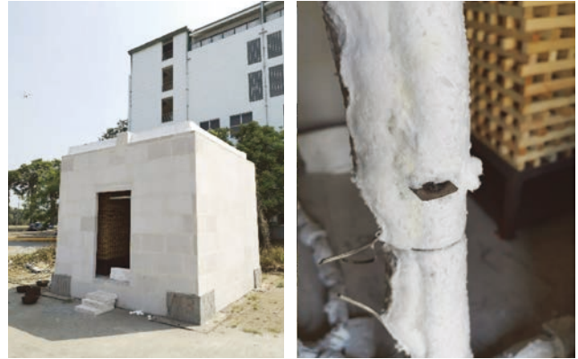
圖 3 隔熱白磚圍封與開口
