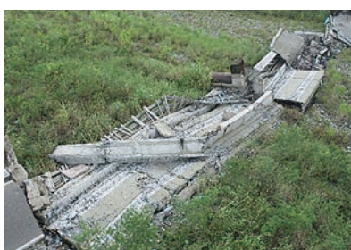
(d) 橋墩傾倒，I 梁及橋面扭曲破裂，受損程度 F
