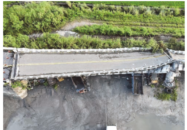
(d) 橋台伸縮縫翹起變形
