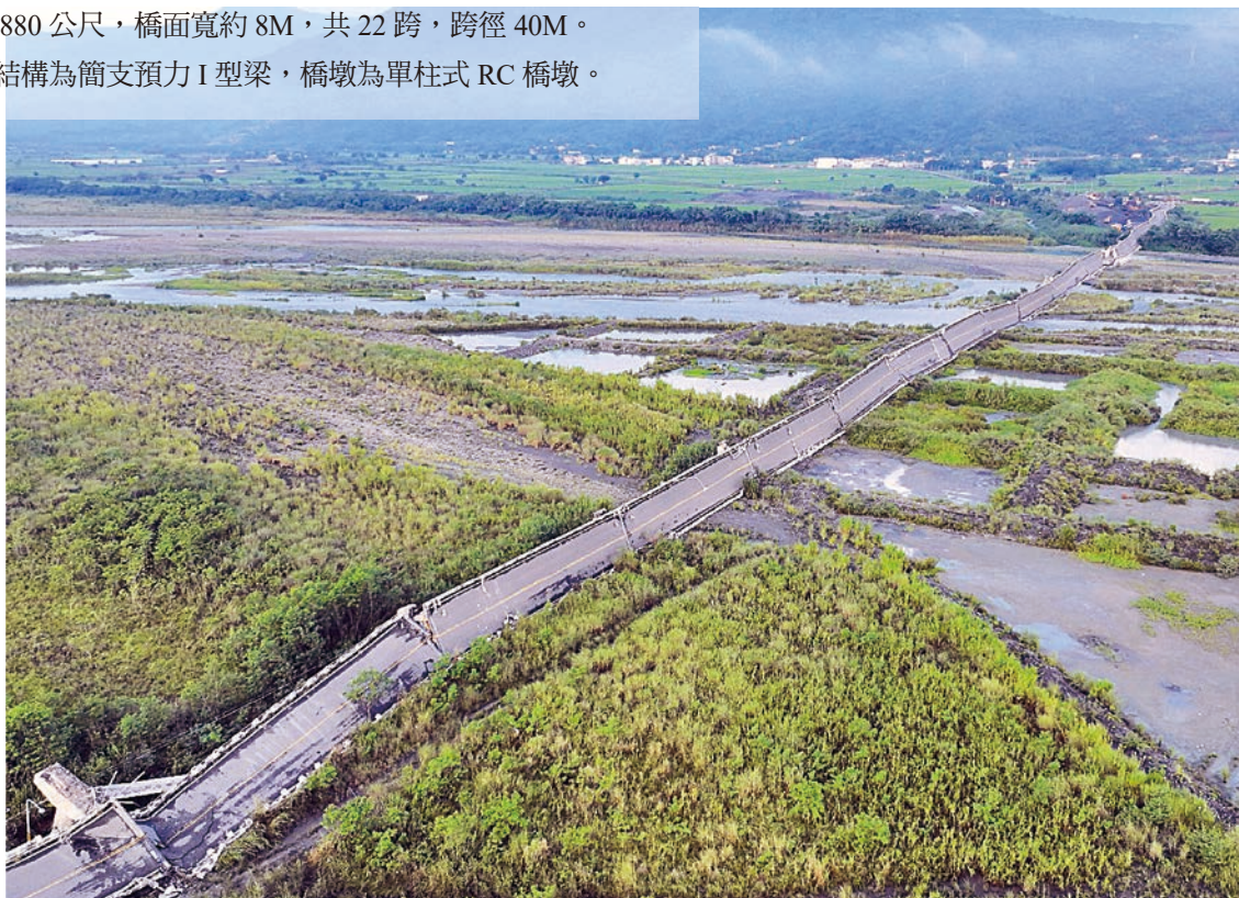
圖 8 高寮大橋全橋崩塌
