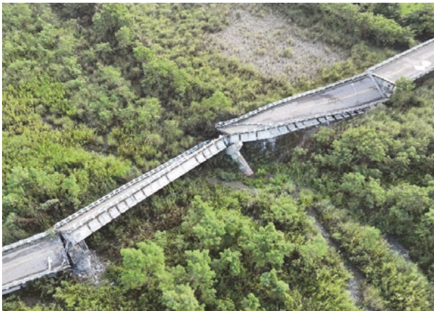
(c) 橋墩斷裂倒塌，受損程度 F
