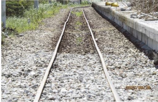
東里車站鐵路軌道錯位，鐵路停駛
