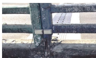
(b) 護欄碰撞裂損、伸縮縫擠壓偏移， 受損程度 C
