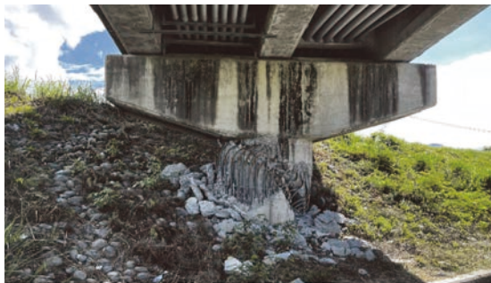
(b) 橋墩柱受剪力全斷面破裂，受損程度 A
