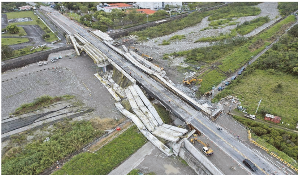
圖 14 2022 年 0323 地震玉興橋施工中預力 I 型梁震落斷裂
