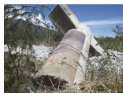
(c) P6 橋墩柱底損壞而傾倒，受損程度 F
