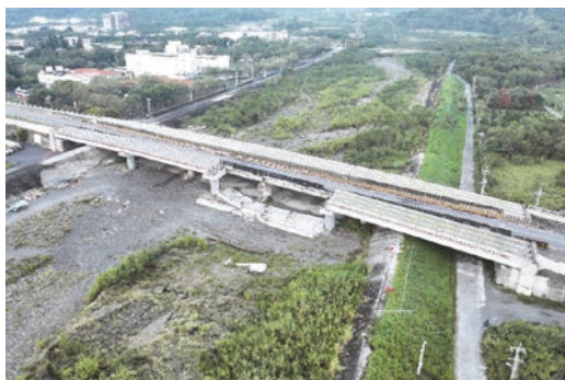
(a) 新建預力 I 型梁掉落斷裂損，受損程度 F
