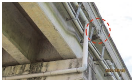
(e) 護欄及橋面板擠壓受損，受損程度 C
