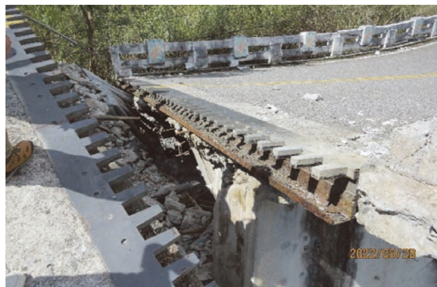
(b) 橋台伸縮縫分離，大梁崩落
