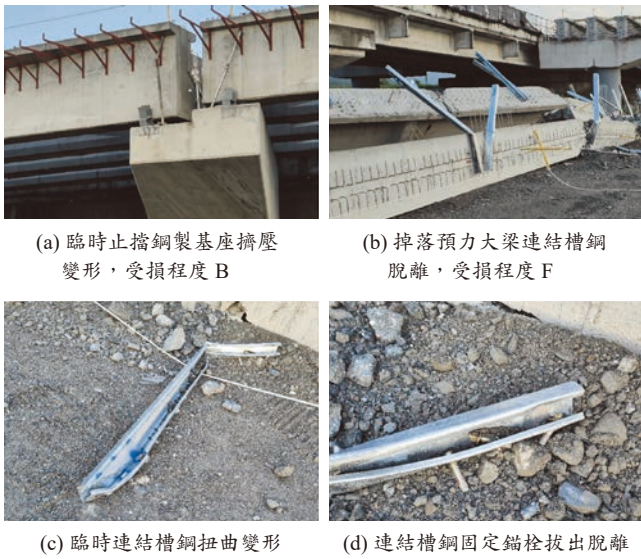
圖 13 玉興橋（施工中新建部分）勘災紀錄（二）
