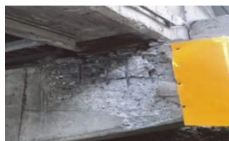
(f) 支承墊滑移、帽梁混凝土剝落， 受損程度 B
