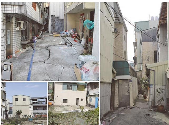
圖 7 發生於安南區惠安街及中西區文和街 (右) 之建築物的傾斜 (不均勻沉陷)
