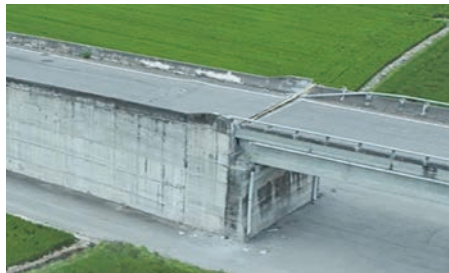
(c) 東橋 A1 橋台局部混凝土剝落、伸縮縫開裂，受損程度 C
