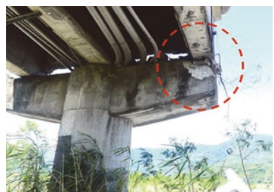
(e) P7 橋墩頂側向止震塊遭大梁碰撞裂損情形，受損程度 B
