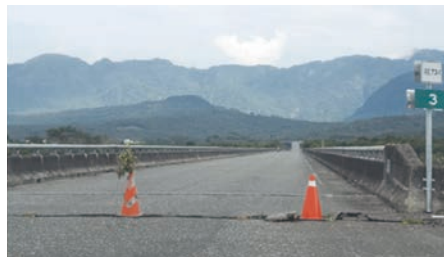
(b) 西橋進橋版處路面開裂，受損程度 C
