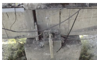
(c) 大梁受推移防落長度不足， 受損程度 B
