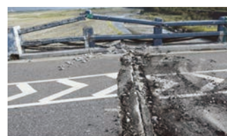
(b) 護欄及橋面板擠壓受損 受損程度 C
