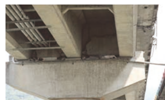
(d) 端隔梁破裂 受損程度 B
