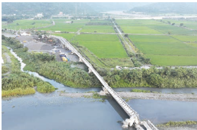
(a) 橋面與大梁落橋，受損程度 F
