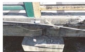
(f) 止震塊破裂、橋面板及 梁端損傷 受損程度 B
