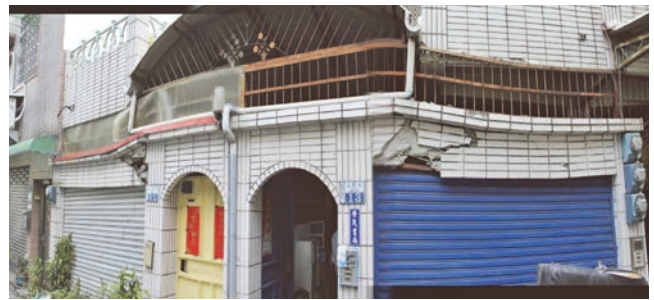
圖 8 發生於新市區三民街之建築物的均勻沉陷
