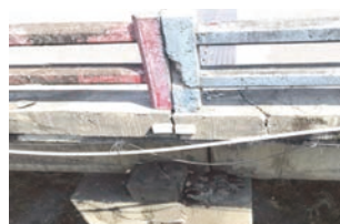
(e) 大梁受推移，護欄、止震塊 及橋面板裂損 受損程度 B
