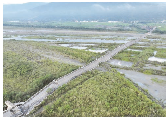
(f) 全橋崩塌，受損程度 F
