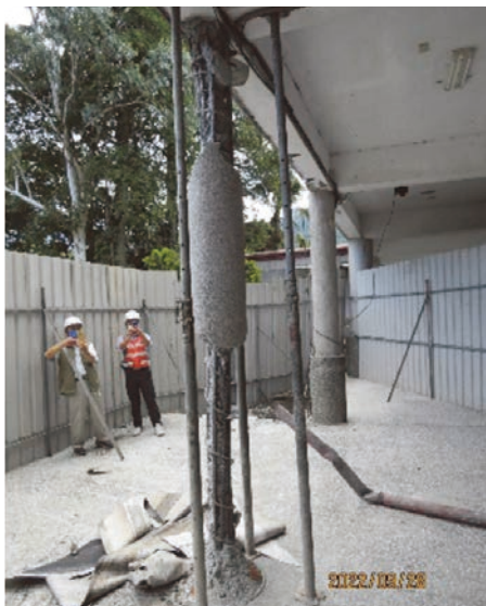
圓柱上下兩端螺旋箍筋保護層混凝土完全剝落損害
