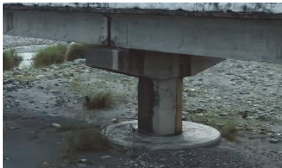
(d) 橋墩柱受剪力表面裂縫，受損程度 C
