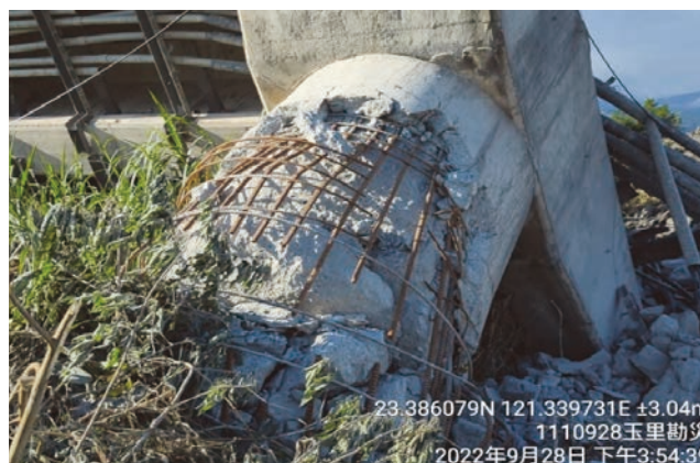
(f) 橋墩混凝土剝落破損，橋柱傾倒
