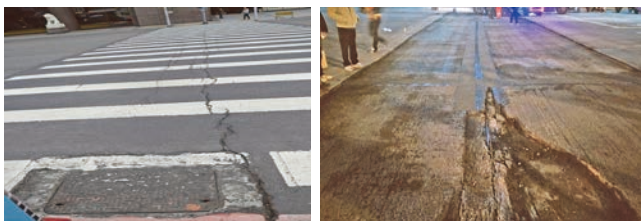
圖 12 市府路地下管線及鋼筋產生之反射裂縫（左）及玻璃纖維改質瀝青貼布完成照片（右）
