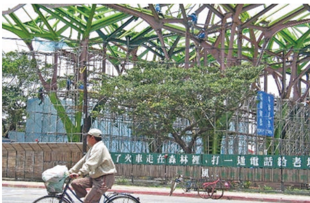
圖 2 施工中的丟丟噹廣場
