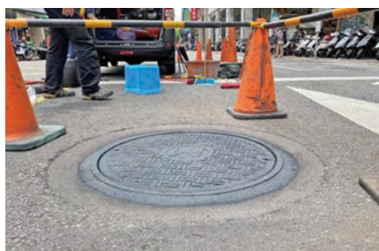
圖 15 孔蓋防滑材料塗佈試辦情形
