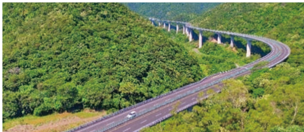
(a) 安朔高架橋
