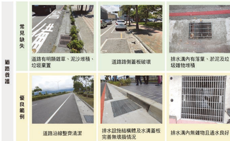
圖 2(a) 道路養護常見缺失及優良範例
