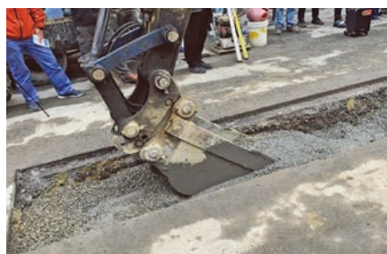
圖 14 管溝回填採高流動性 CLSM 搭配級配粒料試辦情形
