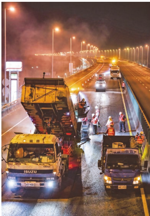
圖 6 國道 1 號夜間施工情形
