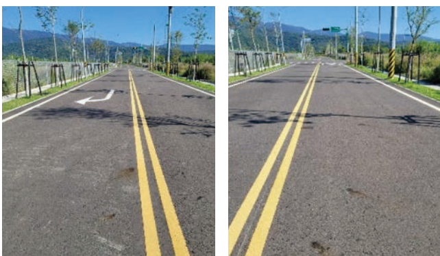
圖 6 使用天然砂石產生之鋪面鏽漬（斑）
