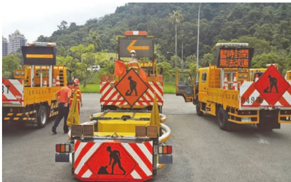
圖 7 國道施工交通維持全面使用附掛式緩撞設施（緩撞車）
