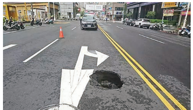
圖 4 大雨後鋪面出現的坑洞 [6]
