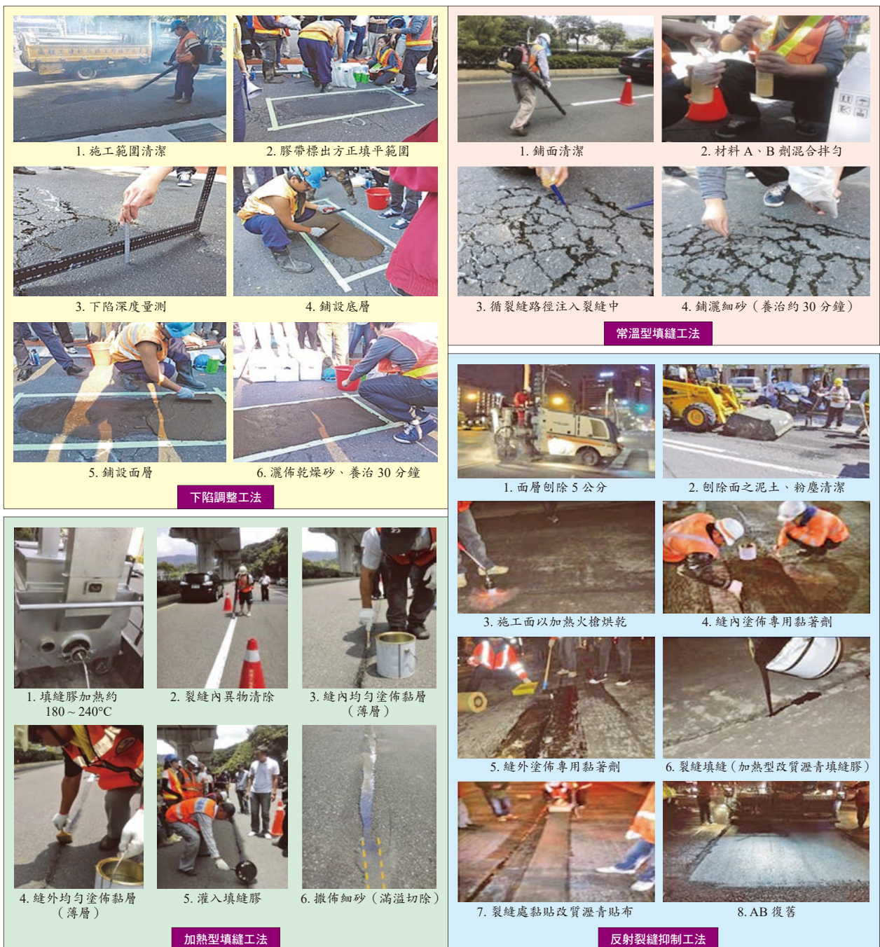
圖 11 鋪面裂縫損壞修補新工法
