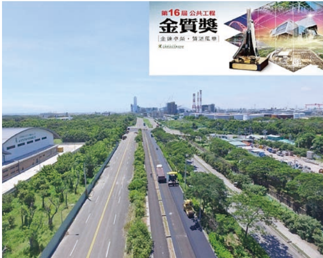
圖 5 轉爐石瀝青混凝土道路：高雄市南星路二期鋪設工程 [7]
