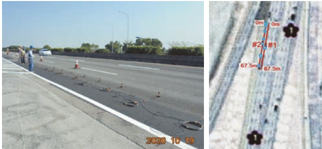
圖 10 國道 1 號南下 250 k 位置進行非破壞檢測（表面波）施作情形 [6]
