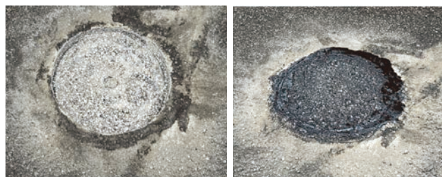
圖 9 坑洞完成銑刨後以圓形瀝青磚回填
