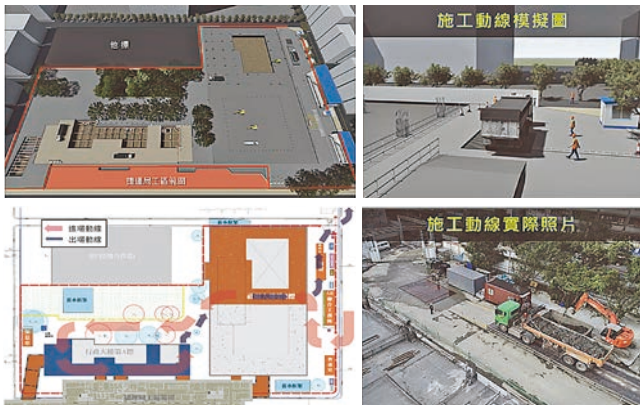
圖 6 邊區逆打版面施工動線模擬圖資
