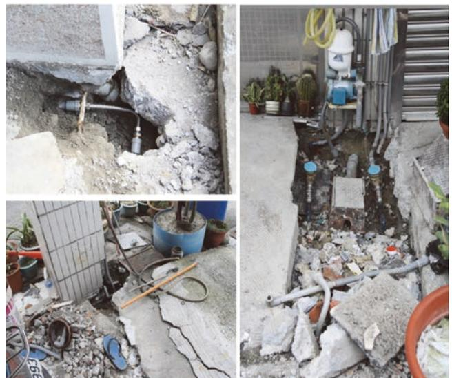
圖 10 發生於新市區三民街之自來水管線斷裂
