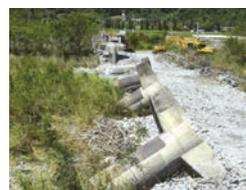
(d) P6 ~ P3 橋墩傾倒（上構已敲除）
