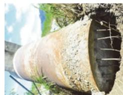
(b) P5 橋墩柱底混凝土澆鑄介面斷裂，鋼筋拉脫傾倒，受損程度 F
