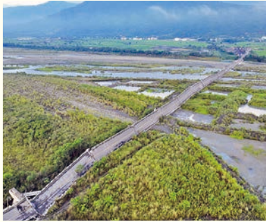
918 花東地震高寮大橋全橋崩塌
