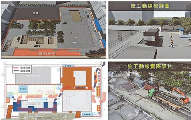
圖 6 邊區逆打版面施工動線模擬圖資
