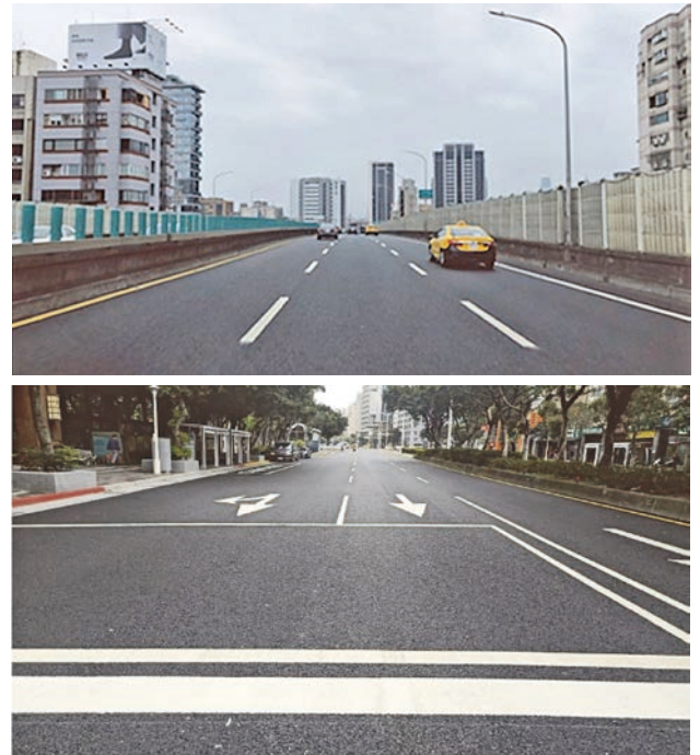
圖 7 臺北市多孔隙瀝青混凝土（PAC）排水鋪面完工照
