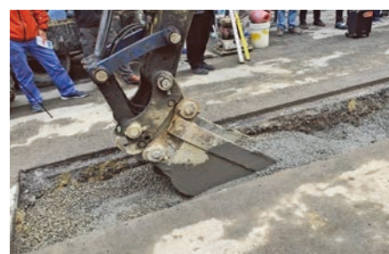
圖 14 管溝回填採高流動性 CLSM 搭配級配粒料試辦情形
