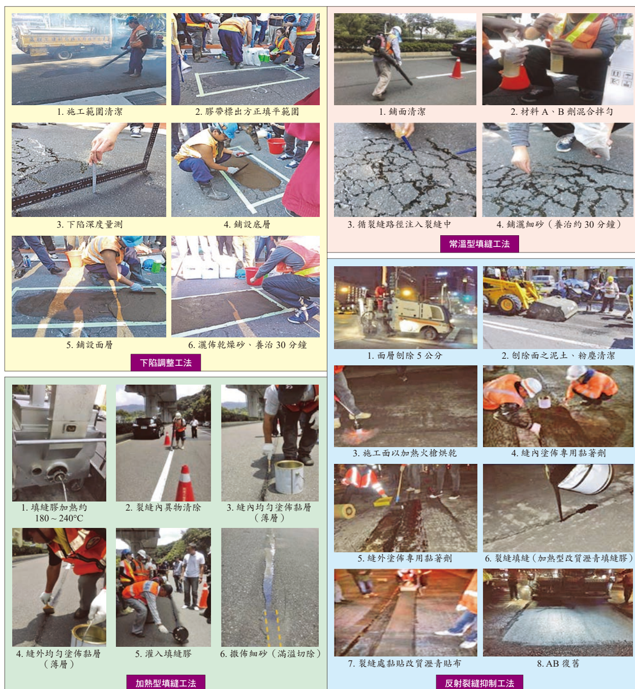
圖 11 鋪面裂縫損壞修補新工法
