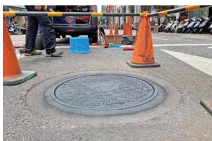
圖 15 孔蓋防滑材料塗佈試辦情形
