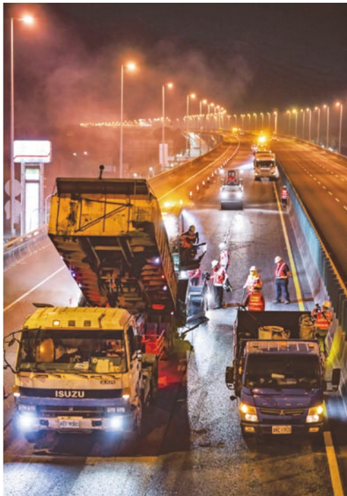
圖 6 國道 1 號夜間施工情形
