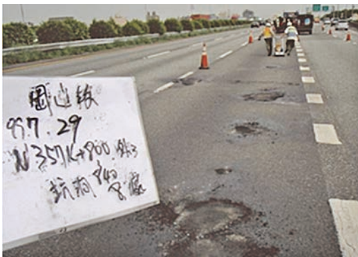
圖 2 早期國道 1 號嚴重坑洞損壞修復施工情形 [2]
