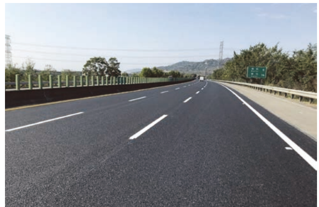
圖 4 國道 3 號名間路段加鋪多孔瀝青混凝土 [4]
