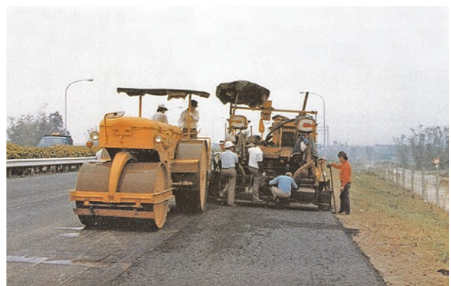
圖 5 早期國道日間施工情形 [5]
