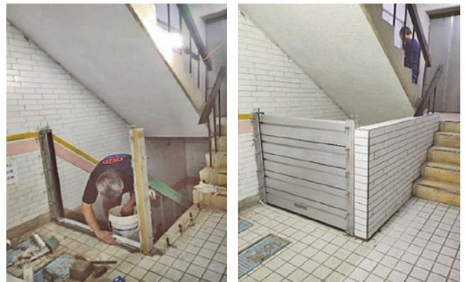
圖 18 防水閘門施作完成照片
