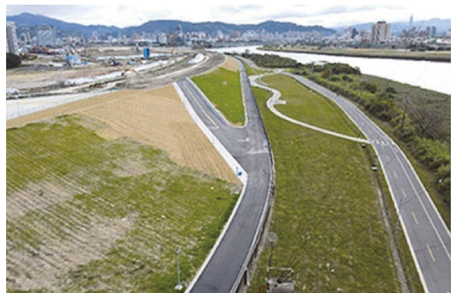
圖 12 雙溪橋至洲美大橋之洲美堤防
