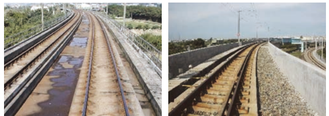
圖 3 臺鐵無碴軌道（左至右依序為版式軌道和 PC 直結式防振軌道）
