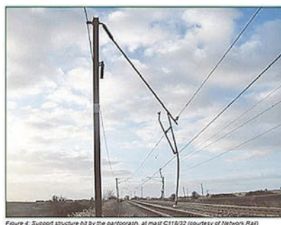
圖 11 列車動態改變，可能使弓網接觸行為改變 [2,3]
