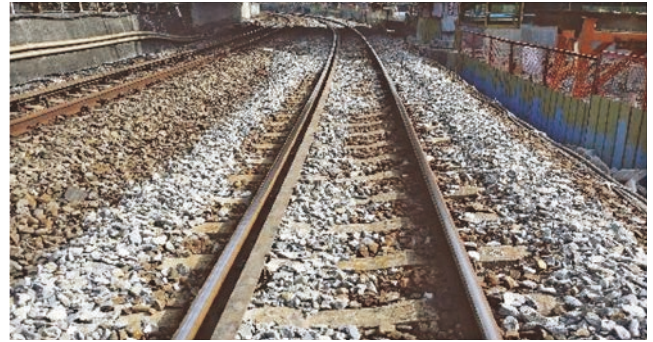
圖 2 臺鐵道碴軌道
