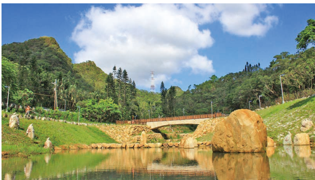
圖 25 金瑞治水園區調洪池
