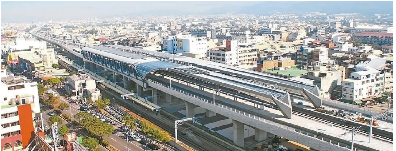
圖 5 臺鐵台中高架路段
