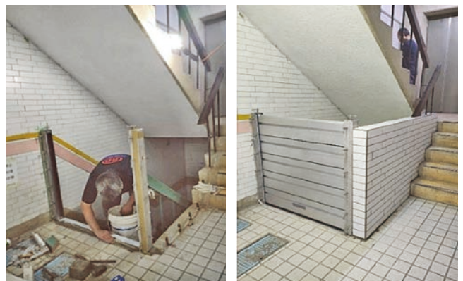
圖 18 防水閘門施作完成照片
