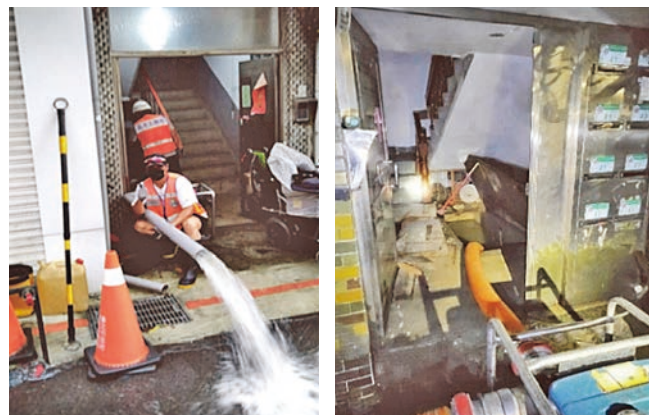
圖 17 家戶未裝設防水閘門積水情形
