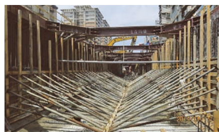
6. 臨時箱涵一昇牆模板支撐
