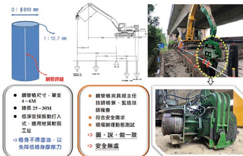
圖 6 鋼管樁規格及驅動設備
