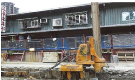
2. 建物保護（靜壓式鋼板樁）施作
