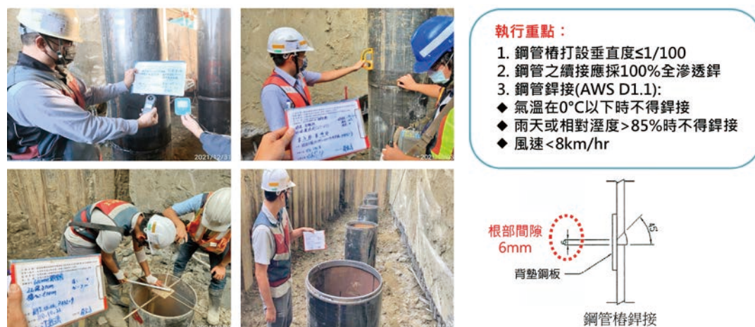
圖 7-3 鋼管樁品質控管
