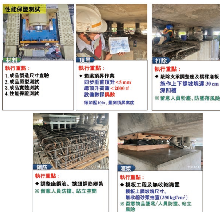
圖 3 鉛心支承施工流程及品質控管作為
