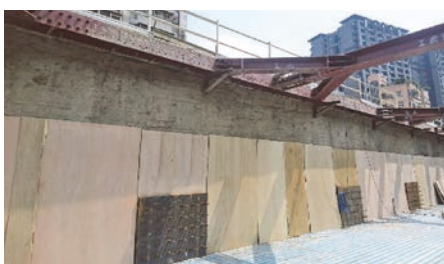
5. 臨時排水箱涵預埋托底鋼板
