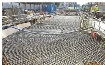
7. 箱涵銜接處鋼筋綁紮
