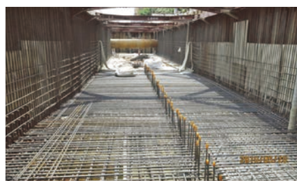
4. 臨時箱涵底板鋼筋綁紮
