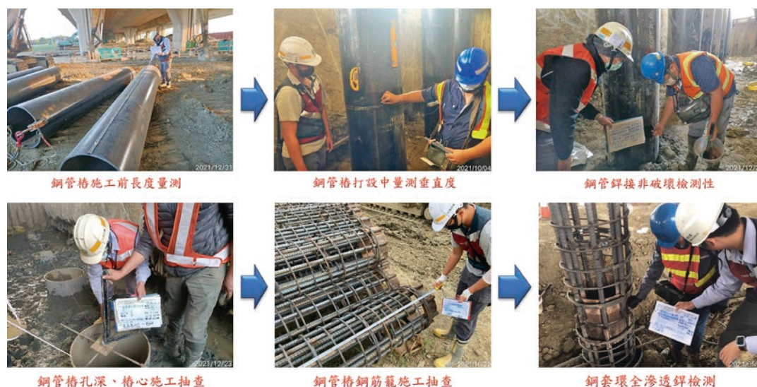
圖 7-2 鋼管樁施工流程
