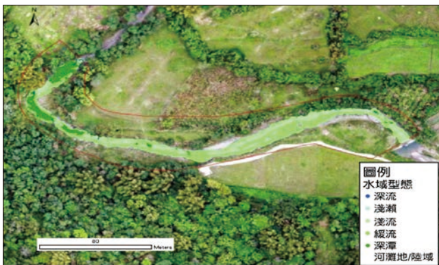
圖 10 水域型態（施工前）
