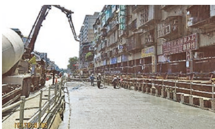
8. 臨時箱涵頂版混凝土澆置
