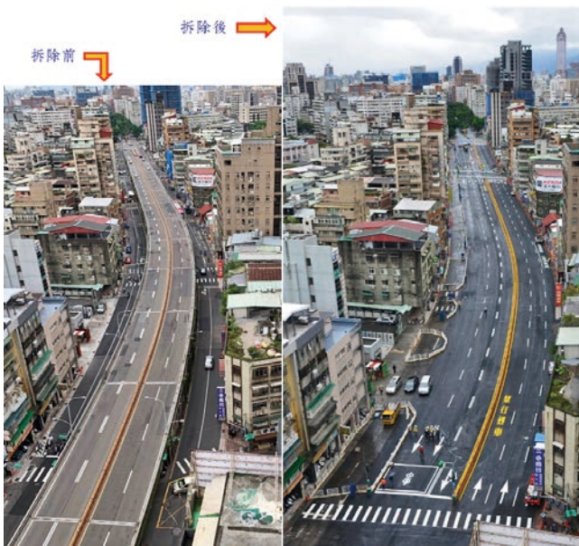
圖 8 重慶南路高架橋拆除前及拆除後之照片
