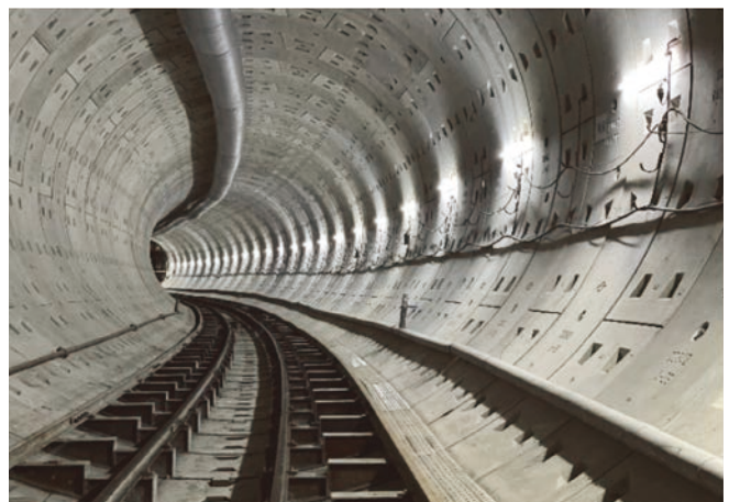
圖 9 環片組裝於潛盾隧道中一景
