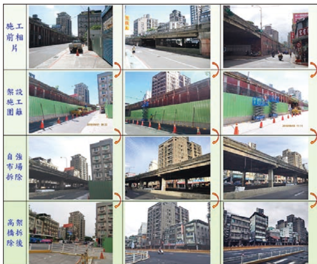
圖 9 自強市場及重慶南路高架橋拆除前及拆除後之照片
