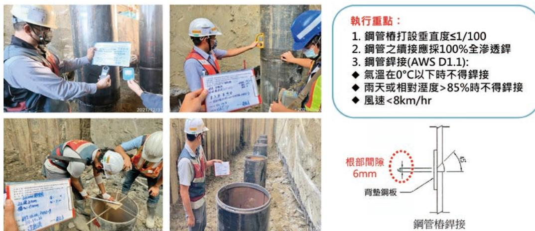
圖 7-3 鋼管樁品質控管
