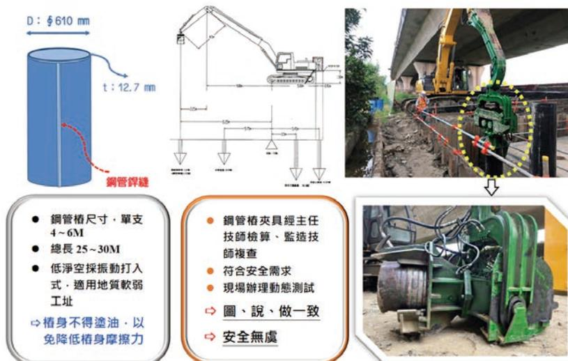
圖 6 鋼管樁規格及驅動設備
