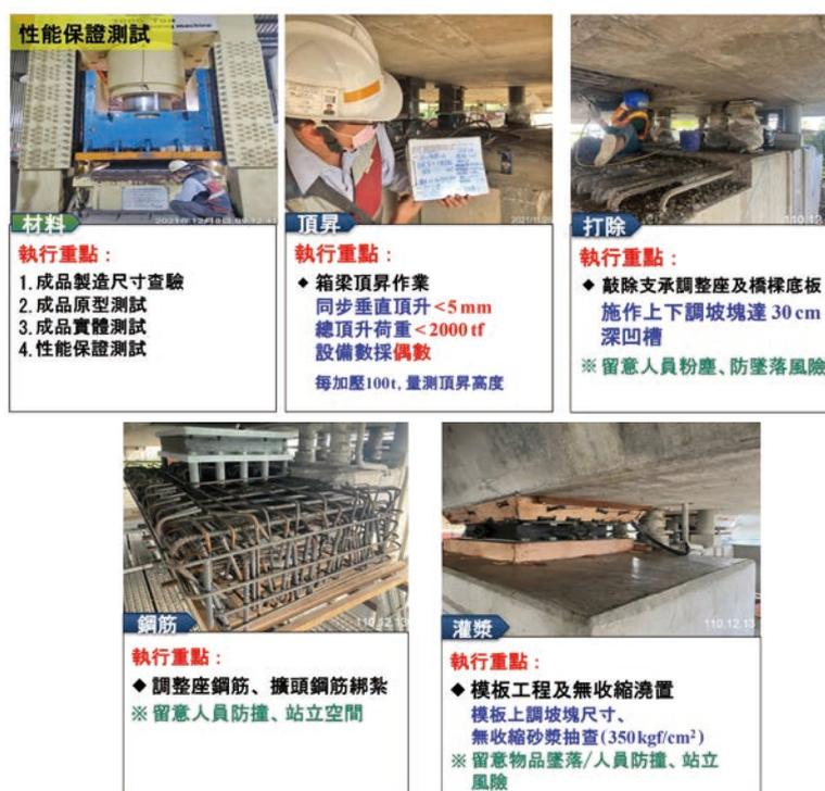
圖 3 鉛心支承施工流程及品質控管作為
