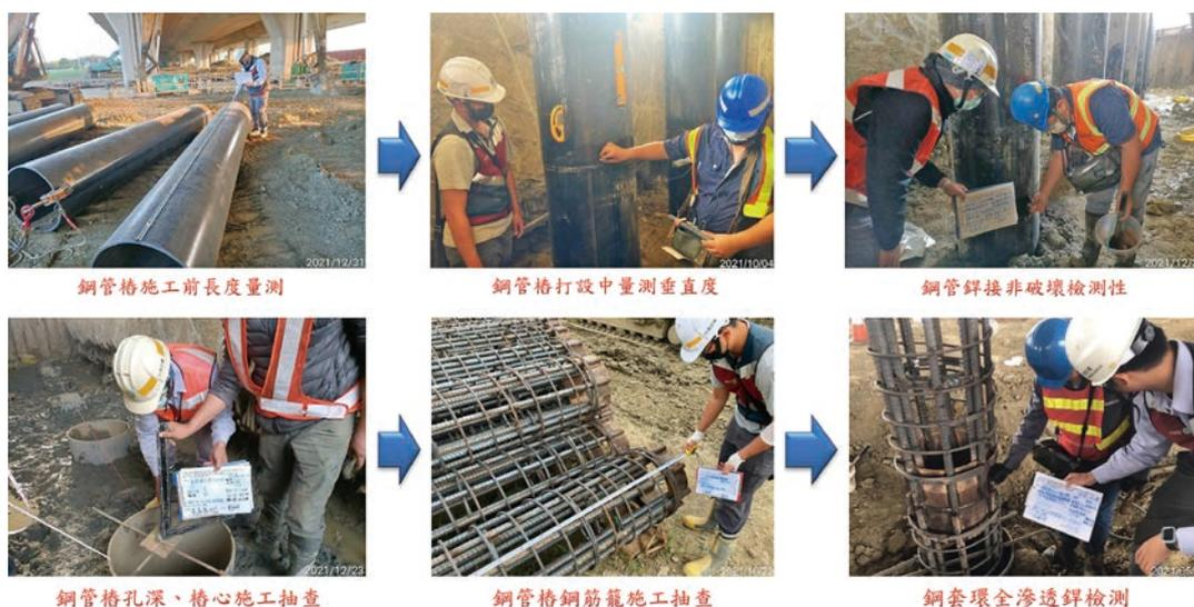
圖 7-2 鋼管樁施工流程
