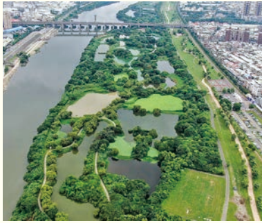
防洪與生態雙贏的水利工程—大漢溪 (經濟部水利署第十河川局提供)
