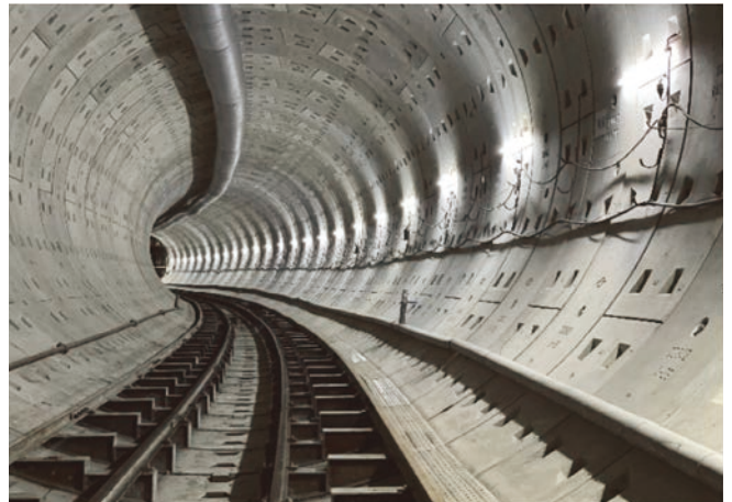
圖 9 環片組裝於潛盾隧道中一景
