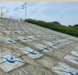
預力防護網工程監測-岩柱安裝應變計實際安
