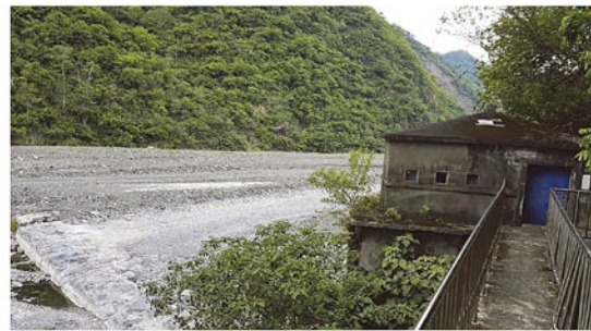
力里溪圳集水廊道
