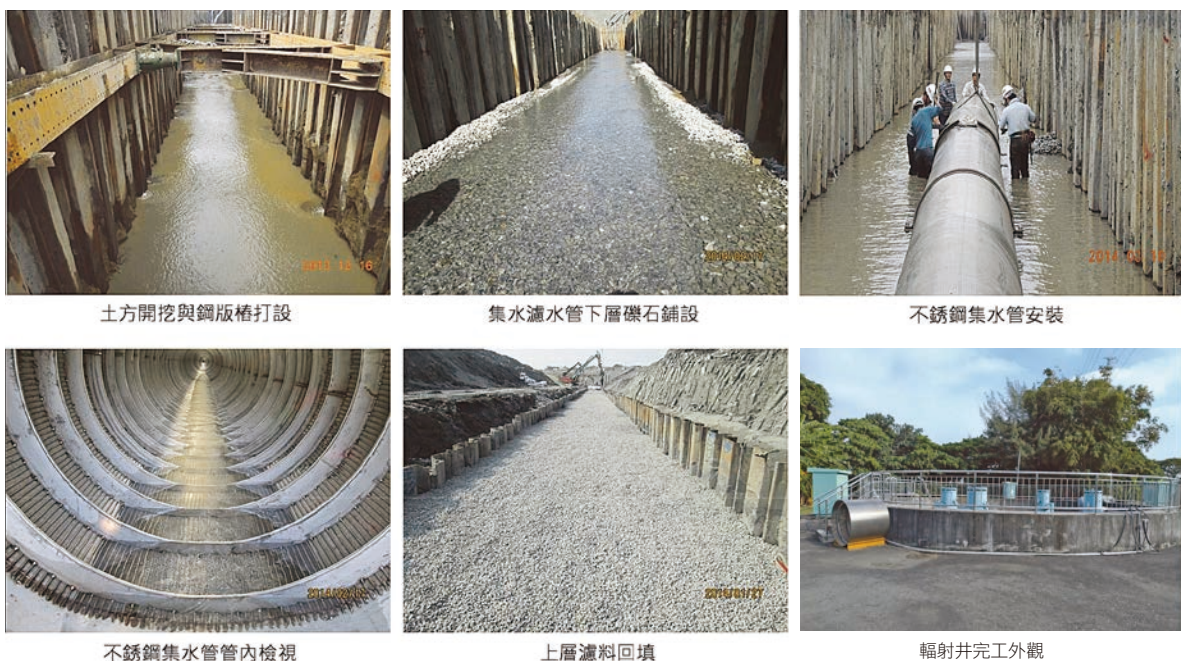
圖 7 竹寮取水站伏流水開發之集水管施工照片圖 (資料來源：台灣自來水公司南區工程處，2020 [20])
