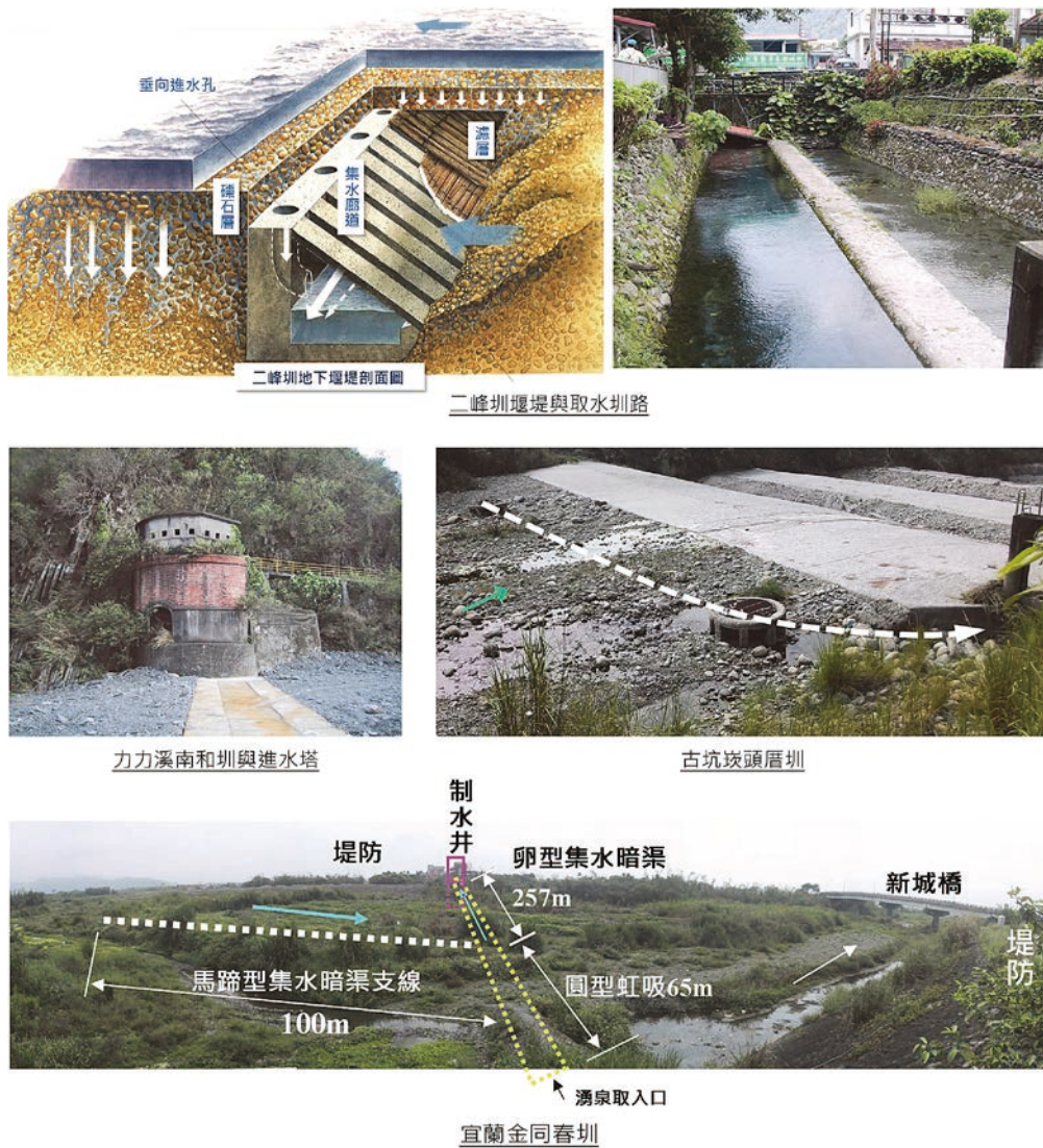
圖6 國內早期所設置之伏流水集水設施現勘照片 (資料來源：屏東縣政府，2021 [11] )
