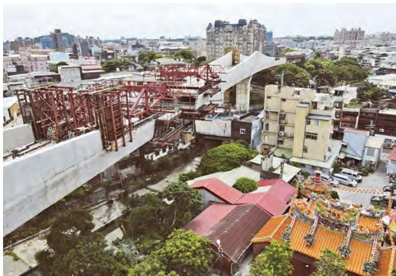
圖 2 施工中之魚鱗式橋及懸臂工作車
