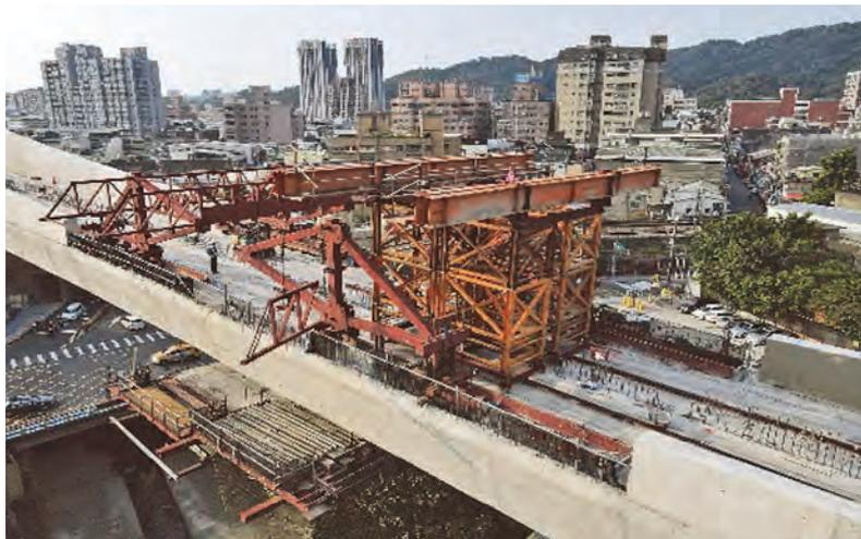
圖 11 從後桁架開始拆卸第 1 台懸臂工作車
