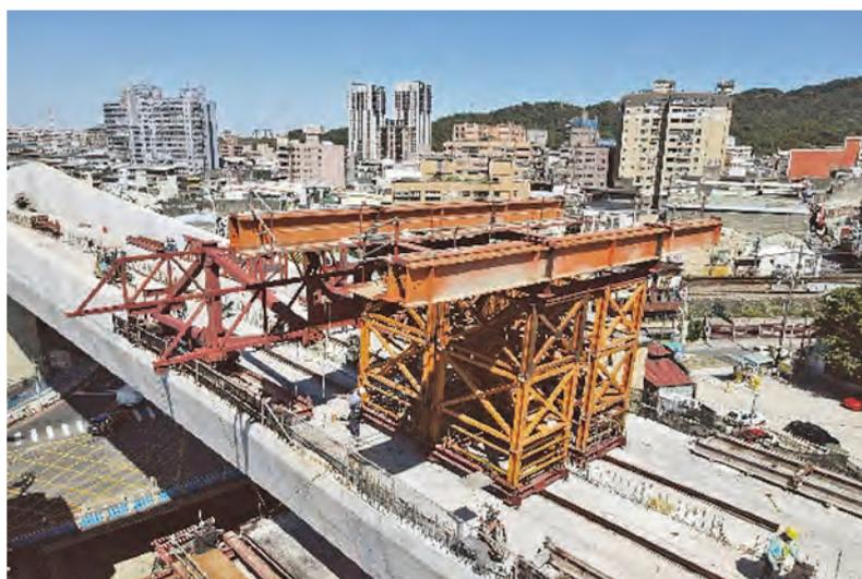
圖 12 從前桁架開始拆卸第 2 台懸臂工作車
