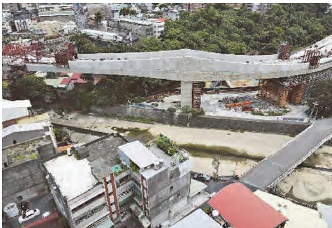
圖 7 魚鱗式胸牆工作車未移動前照片
