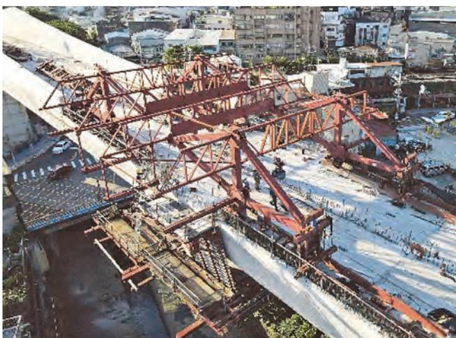
圖 9 拆卸節塊混凝土箱梁外模板照片
