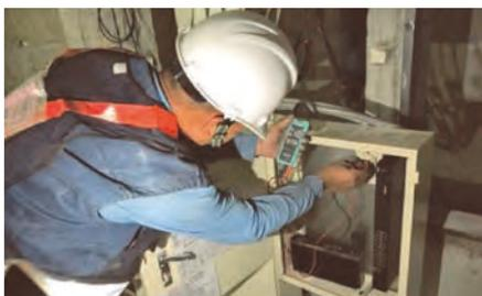
圖 21 供電電源測試照圖資
