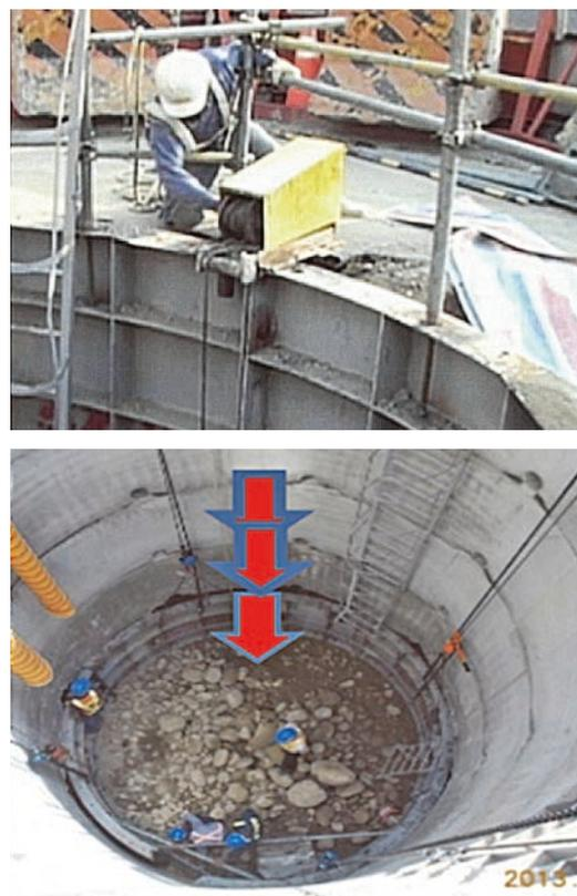
圖 2 滑模設備吊放照片
