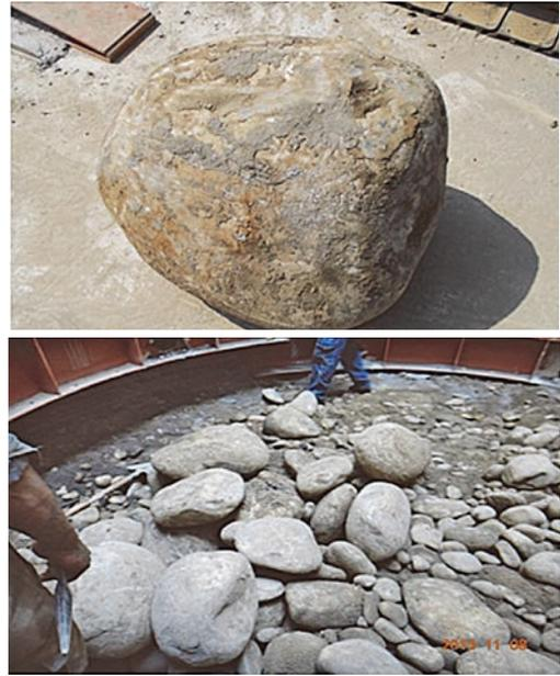
圖 3 井式基礎開挖之卵礫石照片
