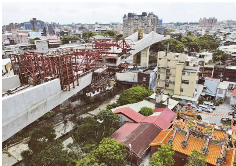
圖 2 施工中之魚鱗式橋及懸臂工作車
