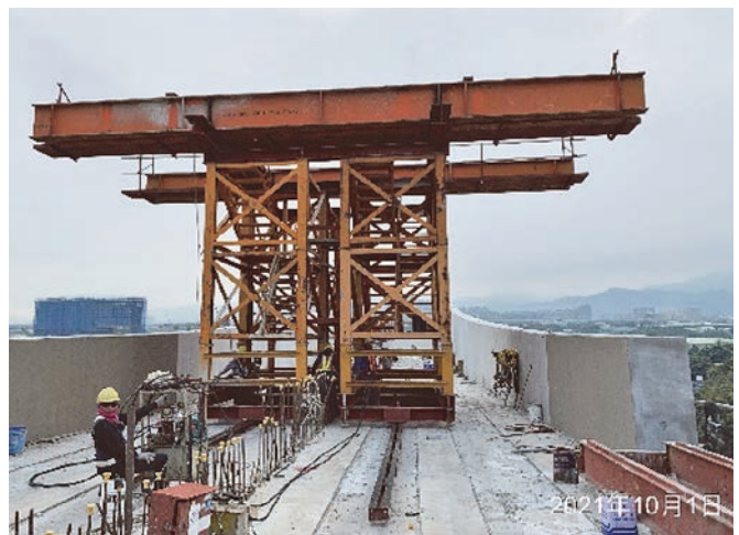
圖 10 拆卸機構組裝片
