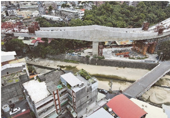
圖 7 魚鱗式胸牆工作車未移動前照片
