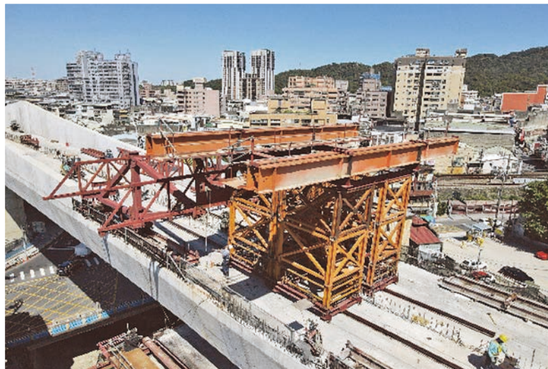
圖 12 從前桁架開始拆卸第 2 台懸臂工作車
