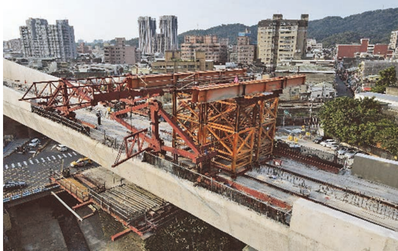
圖 11 從後桁架開始拆卸第 1 台懸臂工作車
