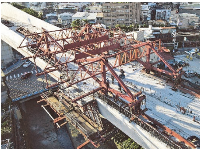
圖 9 拆卸節塊混凝土箱梁外模板照片
