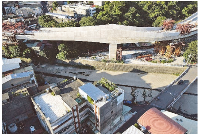
圖 8 魚鱗式胸牆工作車移動後照片
