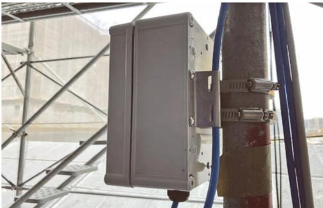
圖 16 感測器 IP65 防水盒及鋼束環配置照圖資
