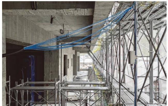
圖 17 感測器訊號電源供應線路佈設照圖資
