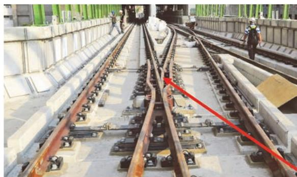
圖 1 可動式岔心 (Swing Nose Crossing, SNX)
