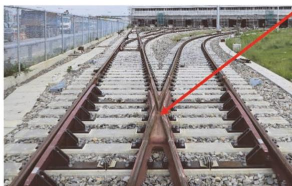
圖 2 固定式岔心 (Fixed Nose Crossing, FNX)
