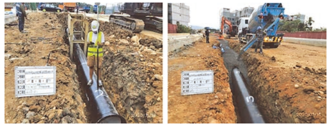
圖 14 新建工程管線在澆置 CLSM 前完成測量工作示意圖
