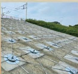
預力防護網工程監測-岩栓安裝應變計實際安
