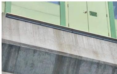
設計隔音牆結構系統時加設泛水板
