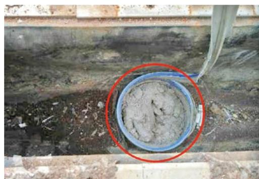
80 φ 橡膠落水管俯視圖 (堵塞時)
