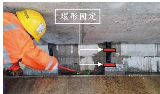
原因②：當伸縮縫排水孔堵塞時造成積水，導致雨水從排水帶兩側流出
