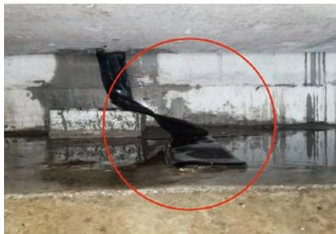
80 φ 橡膠落水管自鋼製落水斗脫落
