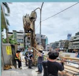
捷運隧道施工期間之地層下陷監測-
