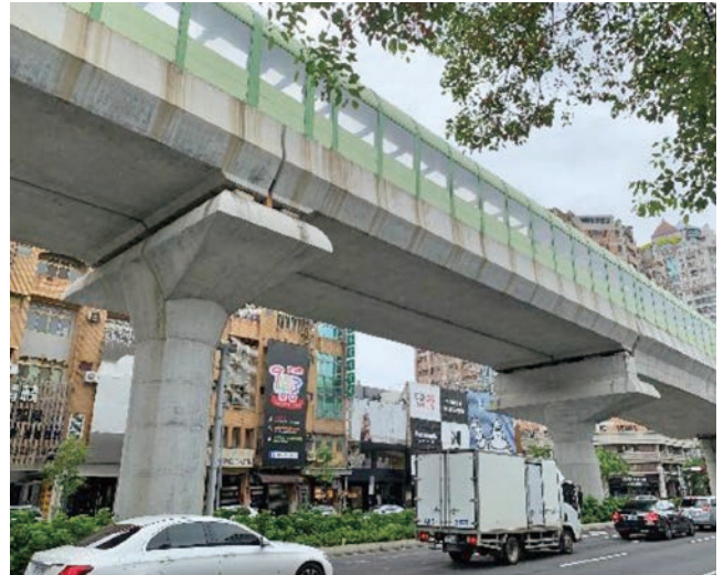
圖 3 設置隔音牆胸牆表面狀況
