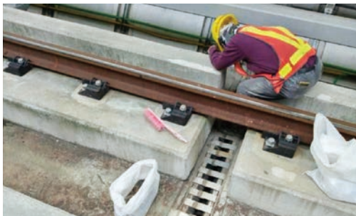
定期派人巡檢及清潔，並可用手電筒照射檢視有無積水造成的反光狀況
