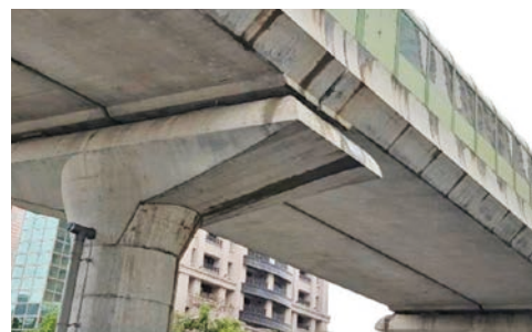
雨水沿著外胸牆造型垂流至帽梁外緣
