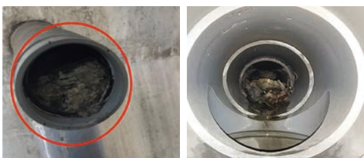
200 φ PVC 管清潔孔堵塞
