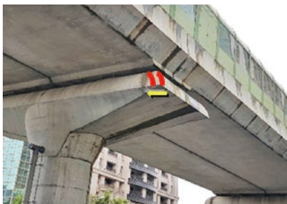
帽梁結構線內縮或改變胸牆造型
