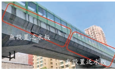
隔音牆有無設置泛水板成果比較
