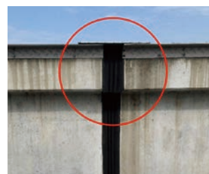
增設囊袋或口型橡膠蓋板
