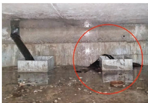
80 φ 橡膠落水管與伸縮縫排水帶接頭脫落
