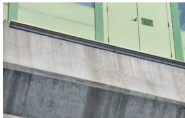
設計隔音牆結構系統時加設泛水板
