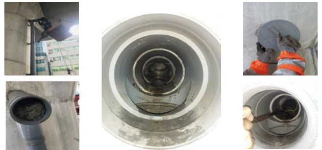
定期派員巡檢墩柱清潔孔及清潔
