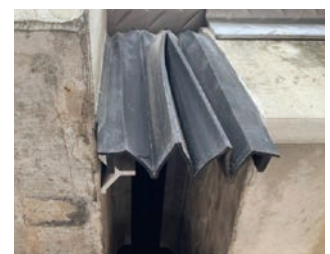
增設囊袋或口型橡膠蓋板
