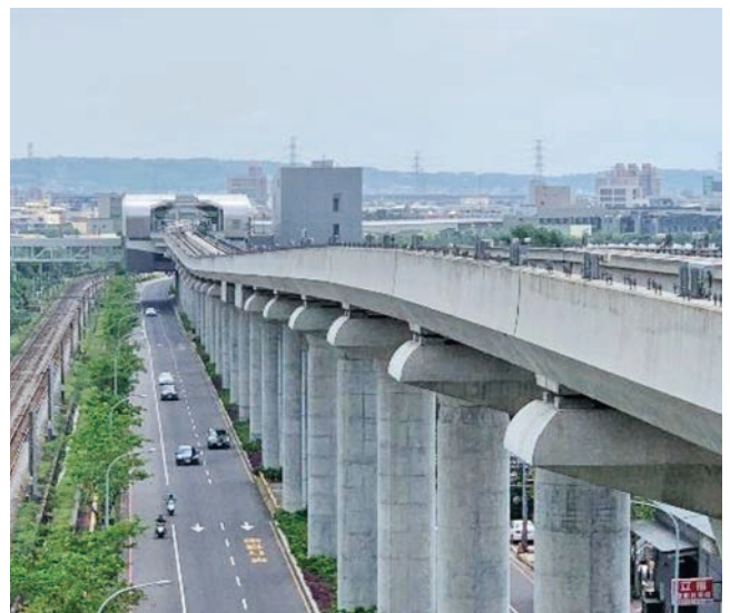
圖 4 無設置隔音牆胸牆表面狀況
