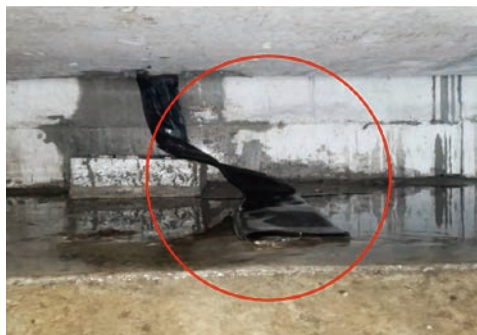
80 φ 橡膠落水管自鋼製落水斗脫落
