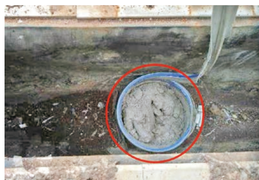
80 φ 橡膠落水管俯視圖 (堵塞時)
