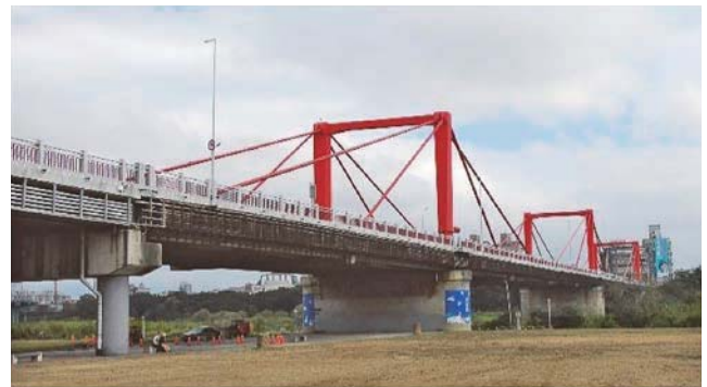
圖 2 光復大橋現況相片
