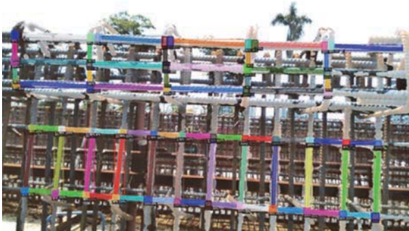
(a) 鋼筋組立結點與間距的實例分割結果
