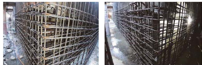
圖 39 墩柱 P10 第二層基礎鋼筋施工相片
