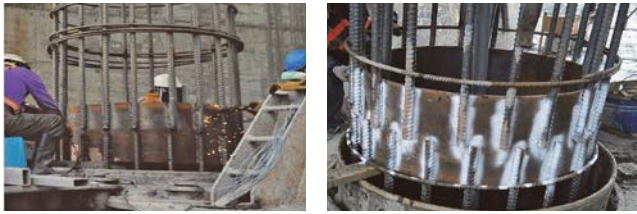
圖 33 基樁鋼筋搭接施工相片
