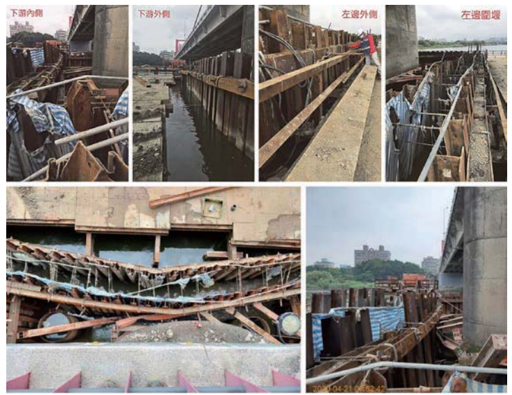
圖 25 墩柱 P10 圍堰變形相片
