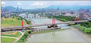
光復大橋墩柱基樁補強現場
