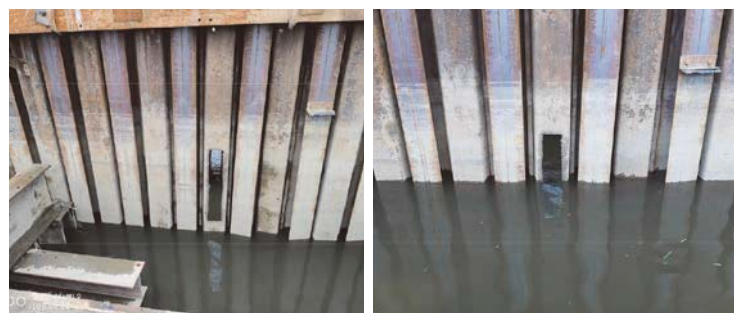
圖 29 雙層鋼板樁圍堰開孔現況相片
