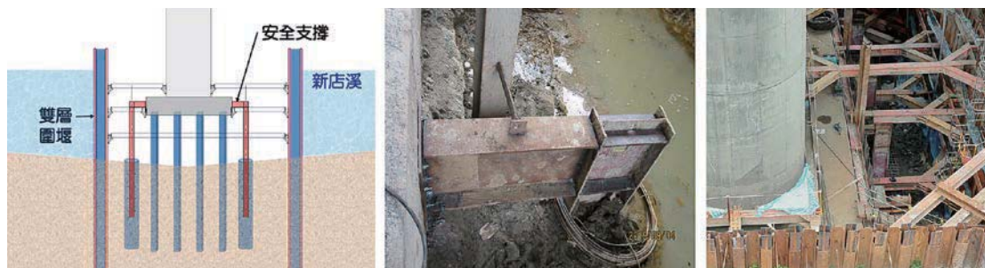
圖 21 墩柱安全支撐示意圖及施工相片
