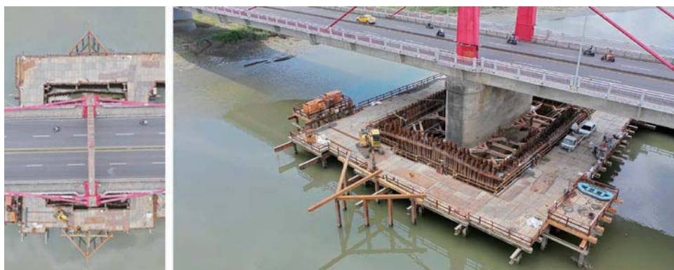
圖 30 圍堰前加設擾流支柱
