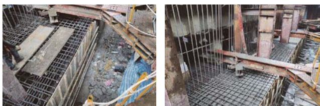
圖 36 墩柱 P10 第一層基礎組模施工相片
