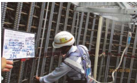
(a) 查驗人員繫上安全繩執行鋼筋查驗的抽樣量測
