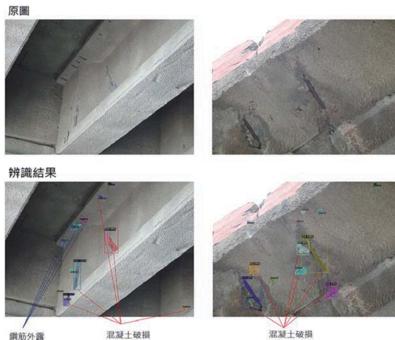
圖 6 模型於橋梁巡檢劣化樣態影像辨識結果
