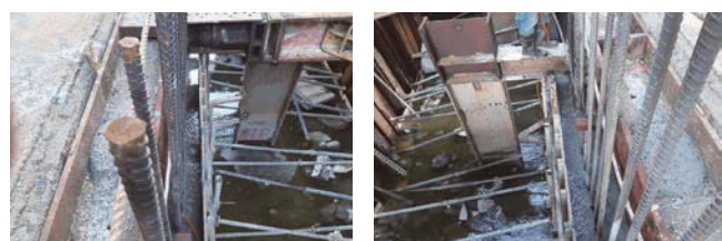
圖 42 墩柱 P10 第二層基礎基礎養護相片
