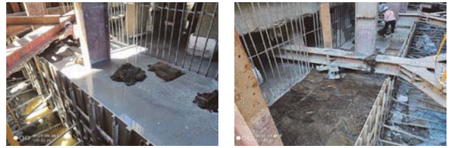
圖 38 墩柱 P10 第一層基礎混凝土養護相片
