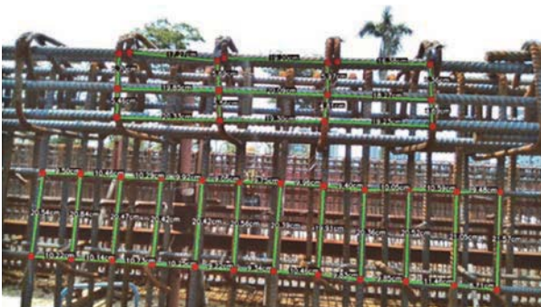
(b) 鋼筋間距真實尺度計算結果
