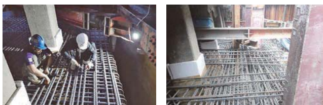
圖 35 墩柱 P10 第一層基礎上層鋼筋施工相片
