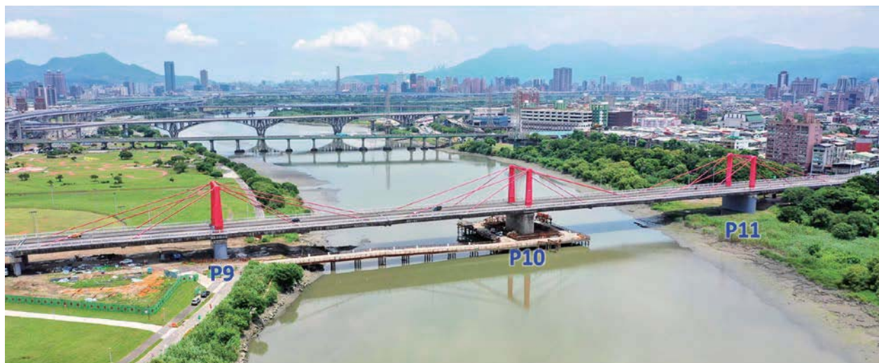
圖 15 墩柱基樁補強現場
