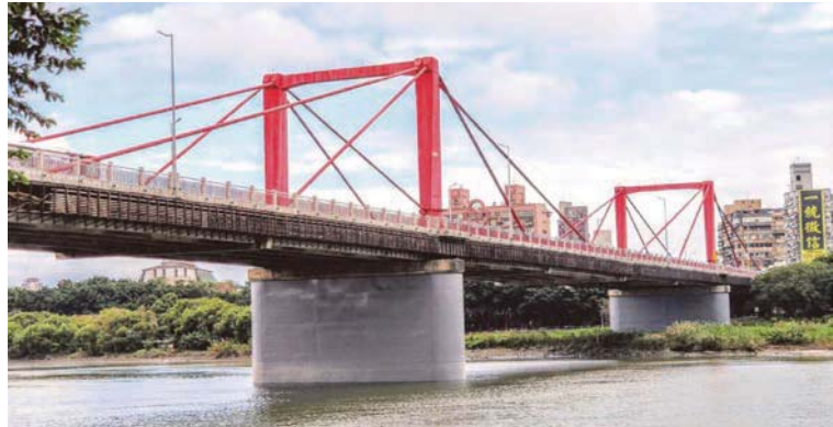
圖 44 光復大橋完工相片
