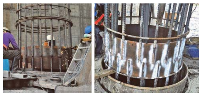
圖 18 基樁鋼筋搭接施工相片
