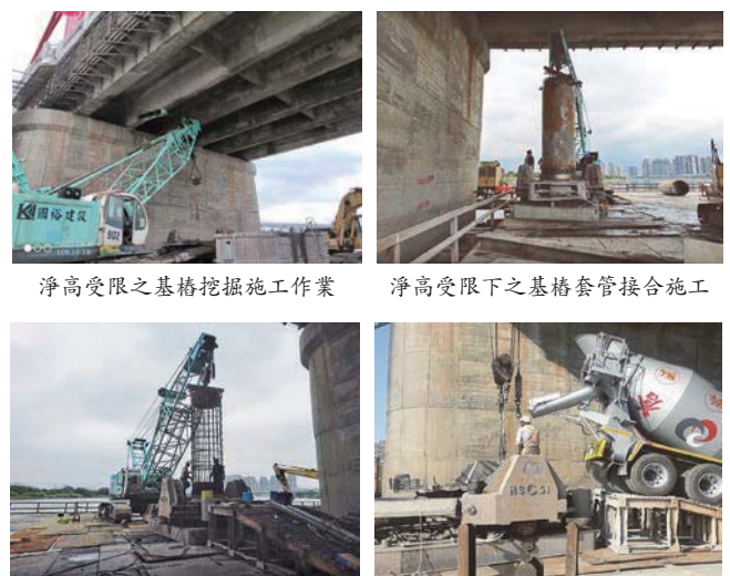
淨高受限之鋼籠搭接施工
