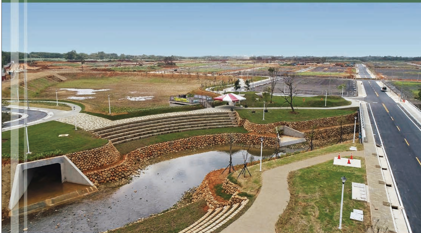
本公司承攬之桃園市觀音區草漯第一、三、六區整體開發單元市地重劃統包工程
