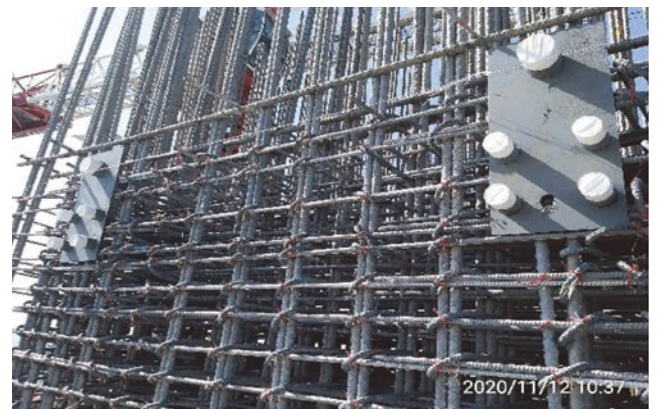
圖 7 柱頭節塊埋設施工托架預留孔
