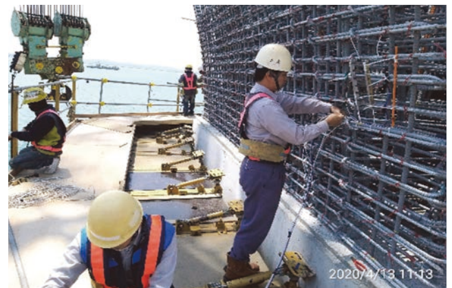
圖 8 鋼筋腐蝕感測器埋設
