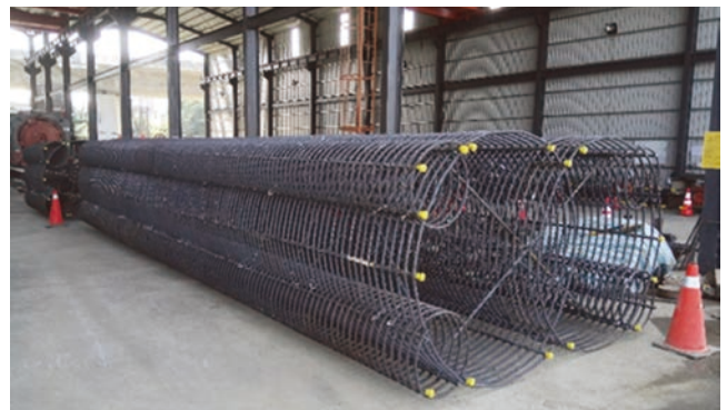
圖 5 螺箍鋼筋籠儲放情形
