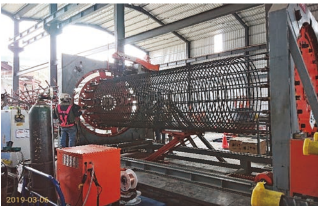
圖 4 螺箍鋼筋籠成型機
