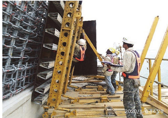
圖 16 系統模板工作平台
