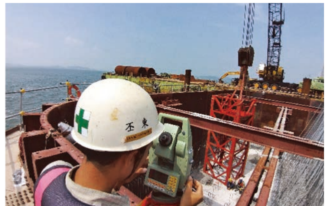
圖 4 樁帽基礎預埋塔吊基座
