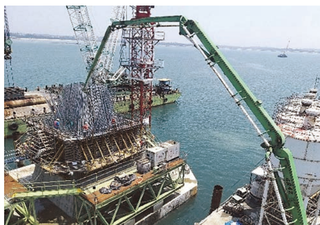
圖 12 墩柱昇層拌和船澆置
