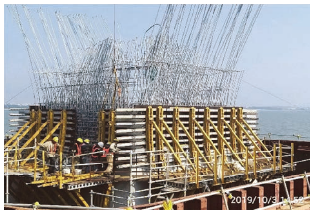
圖 10 EFCO 系統模組立情形
