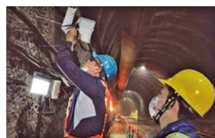
圖 6 BLE Wi-Fi 開道器安裝
