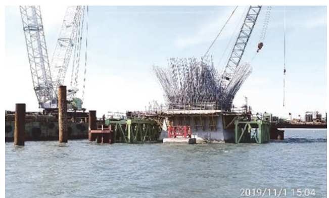
圖 5 樁帽頂部內構台設置
