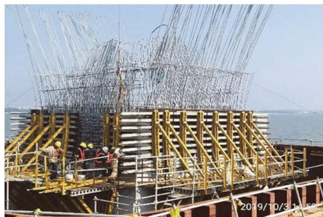
圖 10 EFCO 系統模組立情形
