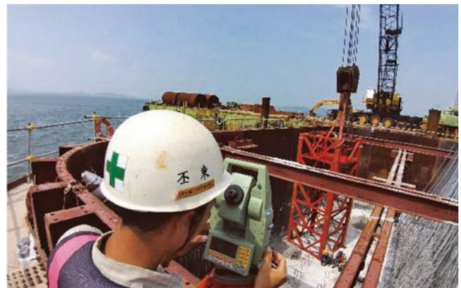
圖 4 樁帽基礎預埋塔吊基座
