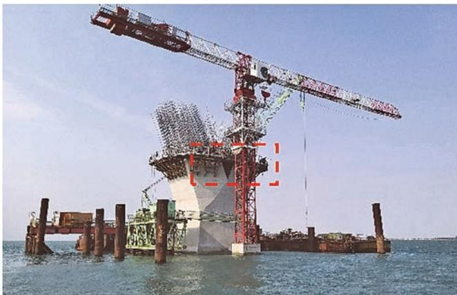
圖 17 墩柱搭配鋼模造型位置
