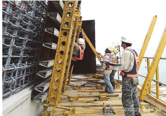
圖 16 系統模板工作平台
