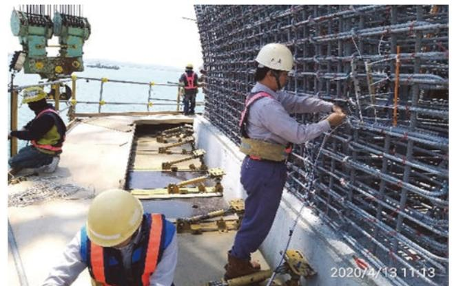
圖 8 鋼筋腐蝕感測器埋設
