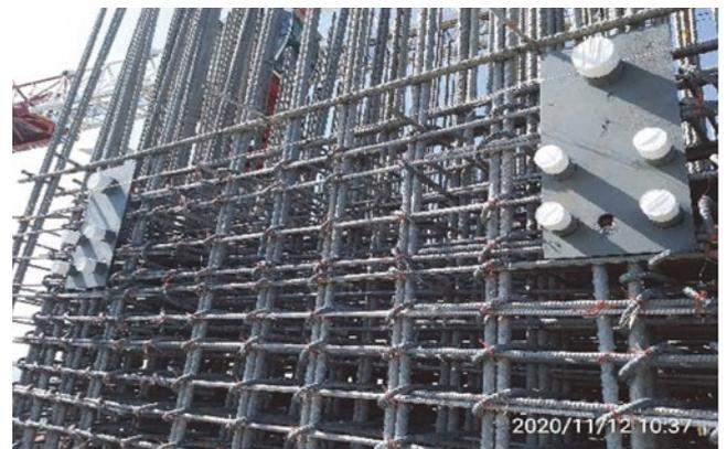
圖 7 柱頭節塊埋設施工托架預留孔
