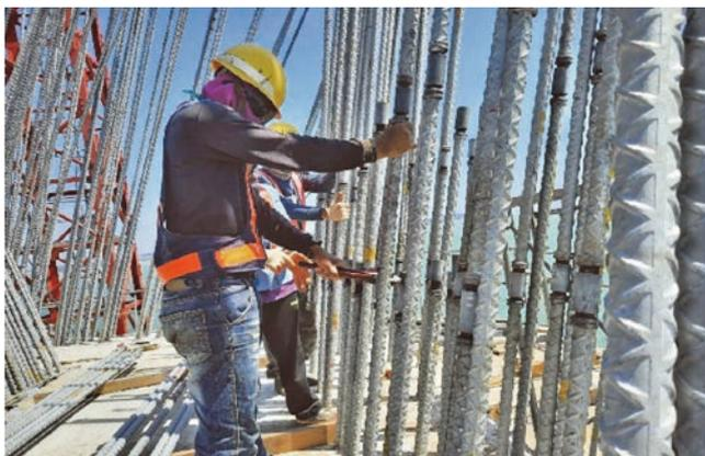
圖 6 主筋 3 件式續接器對鎖施工
