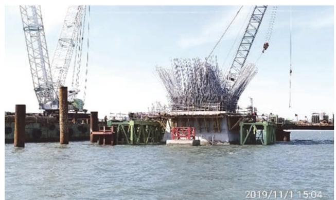
圖 5 樁帽頂部內構台設置
