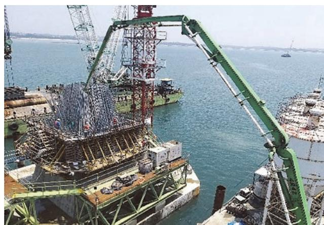
圖 12 墩柱昇層拌和船澆置
