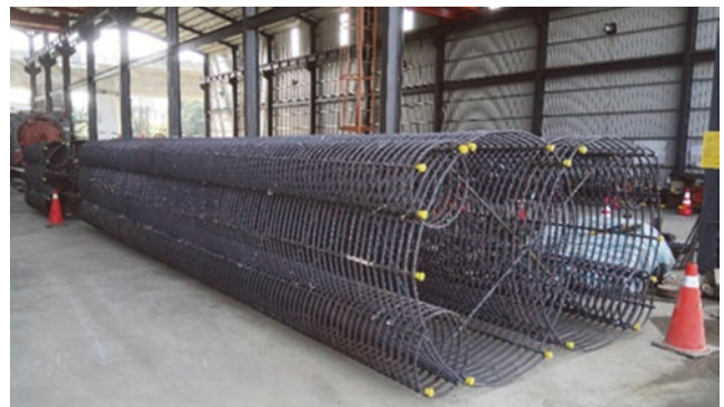
圖 5 螺箍鋼筋籠儲放情形
