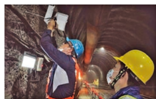
圖 6 BLE Wi-Fi 開道器安裝
