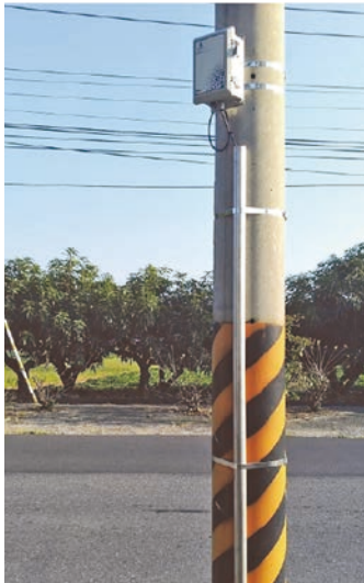
圖 4 路面淹水感知器實際布建 (資料來源：盛邦科技 [5] )
